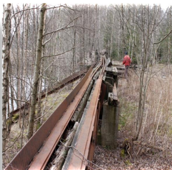
Figur 19: Lämningar i form av upptagningsränna efter det sågverk och impregneringsverk som tidigare fanns vid Sågverksdammen. Foto: Linn Hermansson april 2015.
