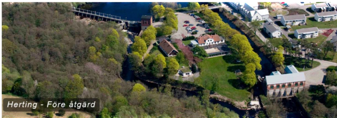
Figur 11: Området kring Herting före utrivningsprojektet. Nere i högra hörnet syns den äldre kraftverksbyggnaden och uppe i mitten ses dammen och den yngre kraftverksbyggnaden. Bildkälla: fvt.se/herting/ den 29 maj 2015
