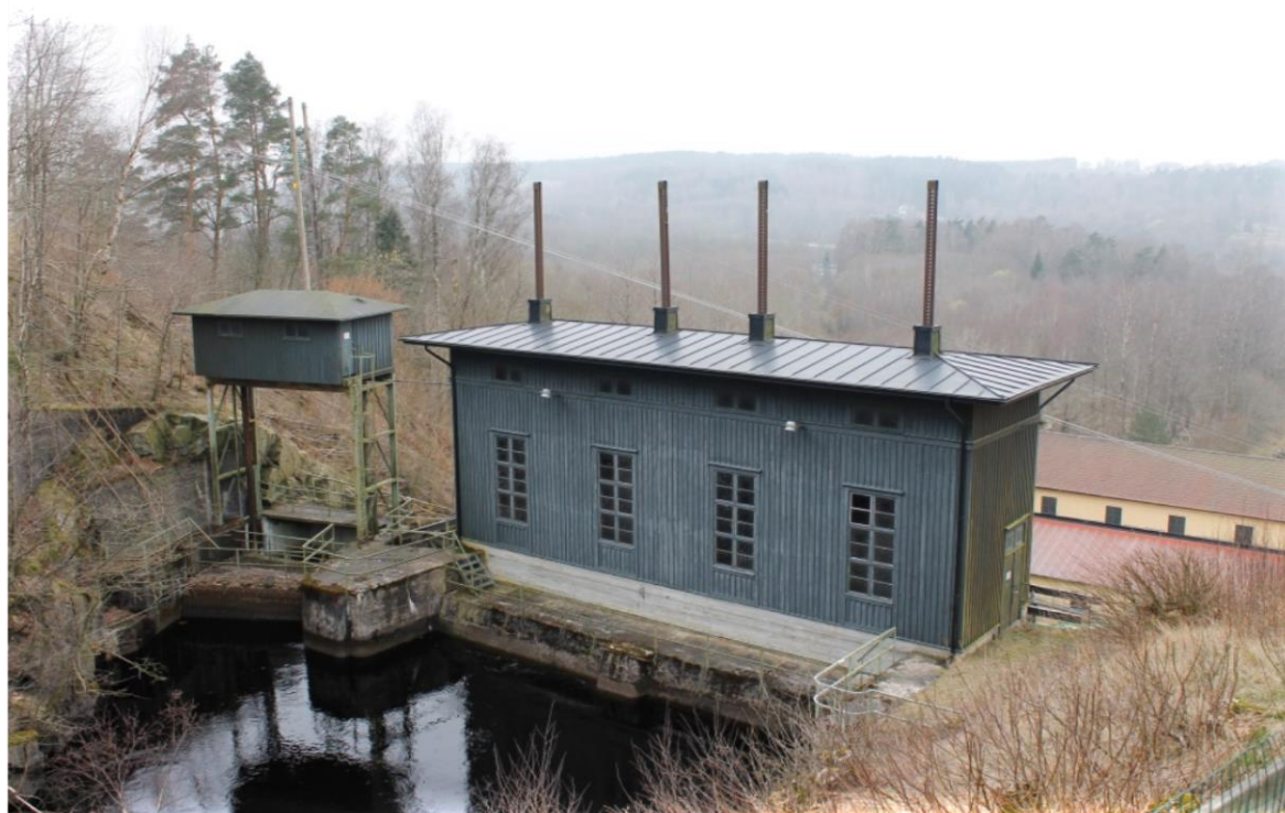
Figur 1: Exempel på ytnyttjande av fallhöjd, Ätrafors kraftverksstation i Halland. Foto: Linn Hermansson april 2015.
