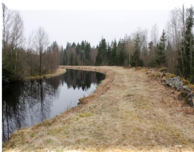
Figur 24: Intagskanalen med kanalvallen på höger sida. Vallen består av massorna som grävdes ur när kanalen anlades i början av 1900-talet. Foto: Linn Hermansson april 2015
