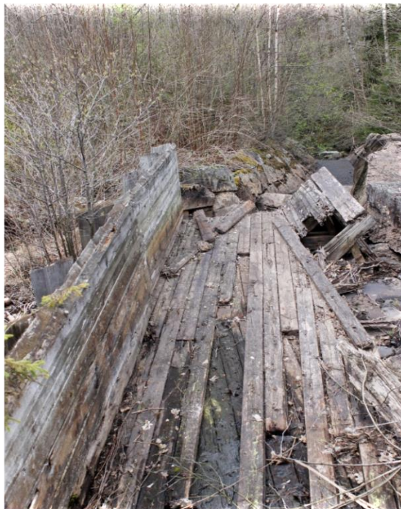
Figur 25: Rester av flottningsränna i trä. Foto: Linn Hermansson april 2015.
