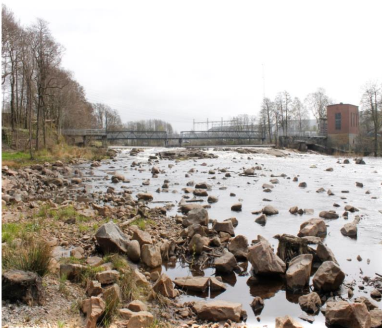
Figur 14: Åtran efter åtgärd vid Herting. Maskinhuset Herting 2 till höger i bild.
