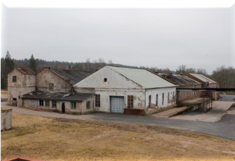
Figur 17: Industrilokaler intill Sågverksdammen där det tidigare funnits ett gjuteri. Foto: Linn Hermansson april 2015.
