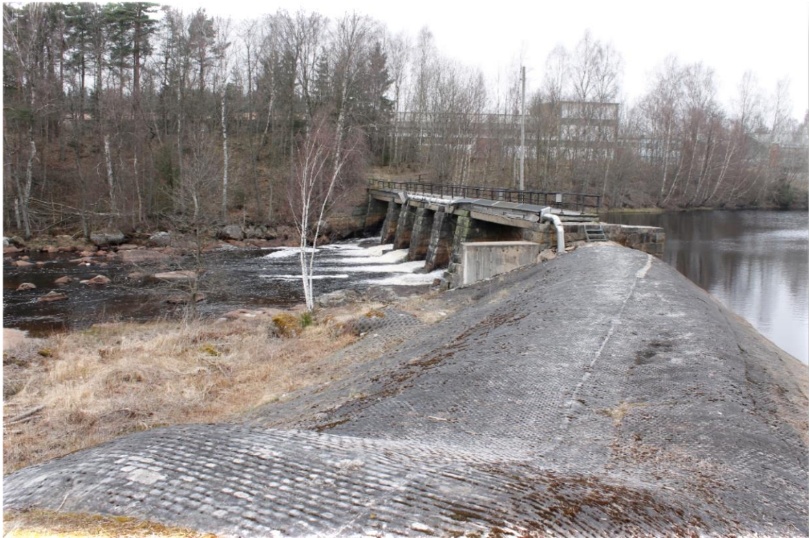
Figur 20: Vallen vid Sågverksdammen med överrinningskydd i form av textilmatta täckt med gummi. I bakgrunden syns dammluckor och bro över Nissan. Foto: Linn Hermansson april 2015
