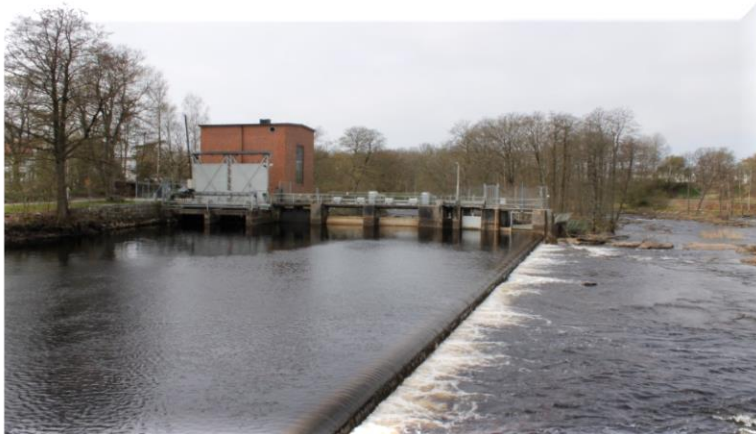
Figur 12: Det äldre av maskinhusen, Herting 2, och en del av Ätran efter åtgärd.
