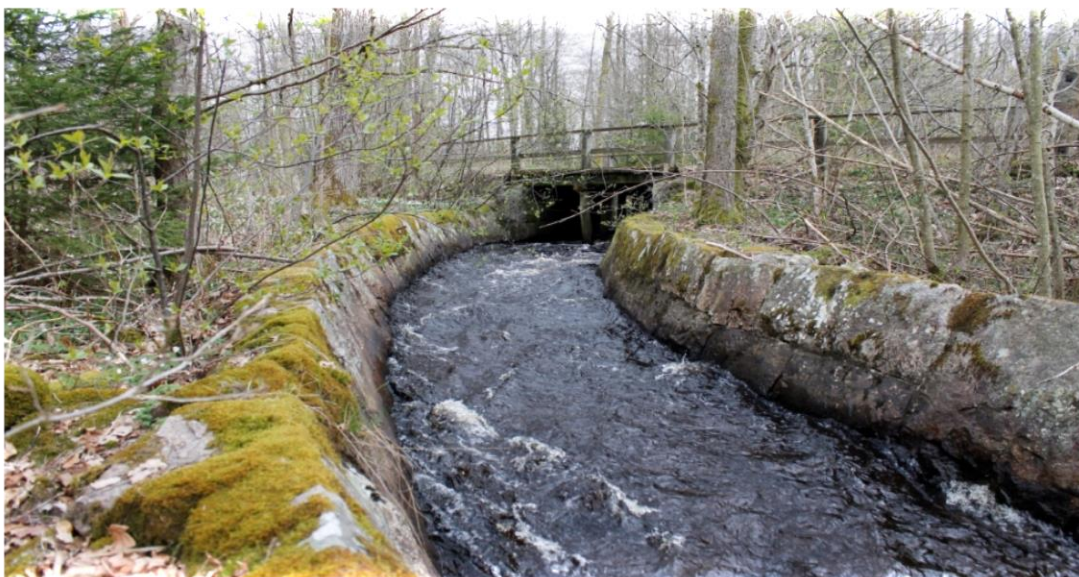
Figur 23: Stensatt flottningsränna intill utloppet från f.d. kraftverksstationen. Foto: Linn Hermansson april 2015.
