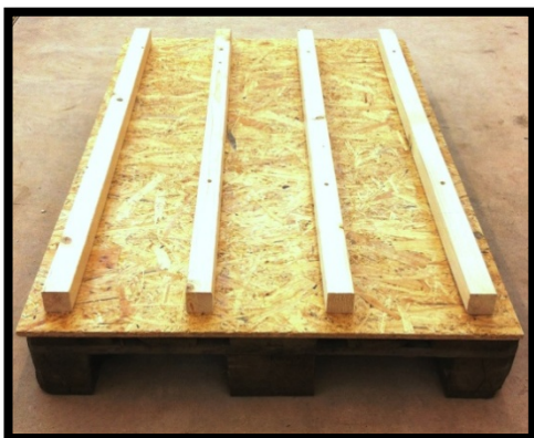
Figur 10. 2x2" regler fastskruvade i OSB-skiva.
