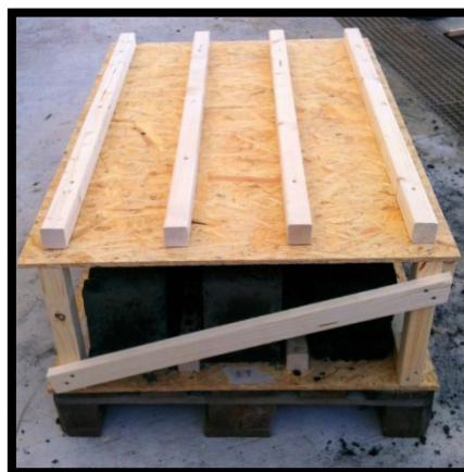
Figur 13. Hörnstolpar och nästa våning monterad med strävning.
