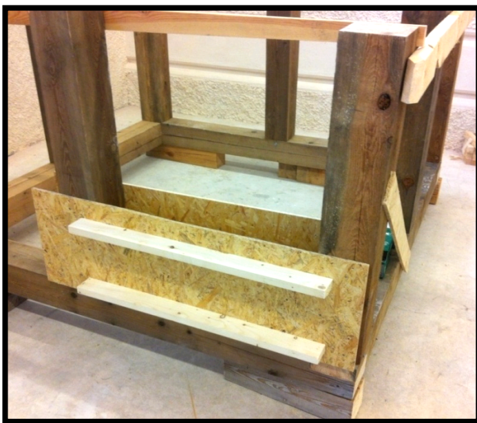
Figur 17. Montering av formar inför direktfyllning.
