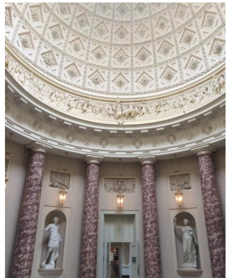
Fig. 1. Marble saloon på Stowe school i England. Det imponerande kupoltaket med stuckornament i både kalkstuck och gips, samt kolonner med scagliola .
