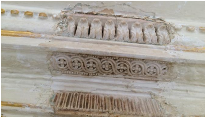
Fig. 3. Ett tydligt exempel där gipsstuckaturens dekorativa detaljer har gömts under tjocka färglager. Här har, på alla tre dekorativa ytor, ett lyckat färgborttagningstest utförts med en lösningsmedelsbaserad massa, vattenånga under tryck samt mekanisk avlägsning.
