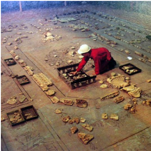
Fig. 8. Förberedande arbete av rekonstruktionen av Uppark House stucktak Foto: Cliveden Conservation Workshops
