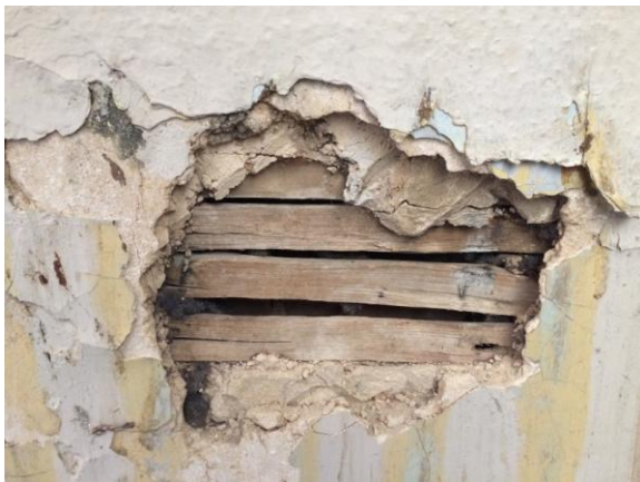
Fig. 2. Bärläkten bestående av träribbor (eng. lathwork ). Man kan här se hur stucken är uppbyggd i flera lager.
