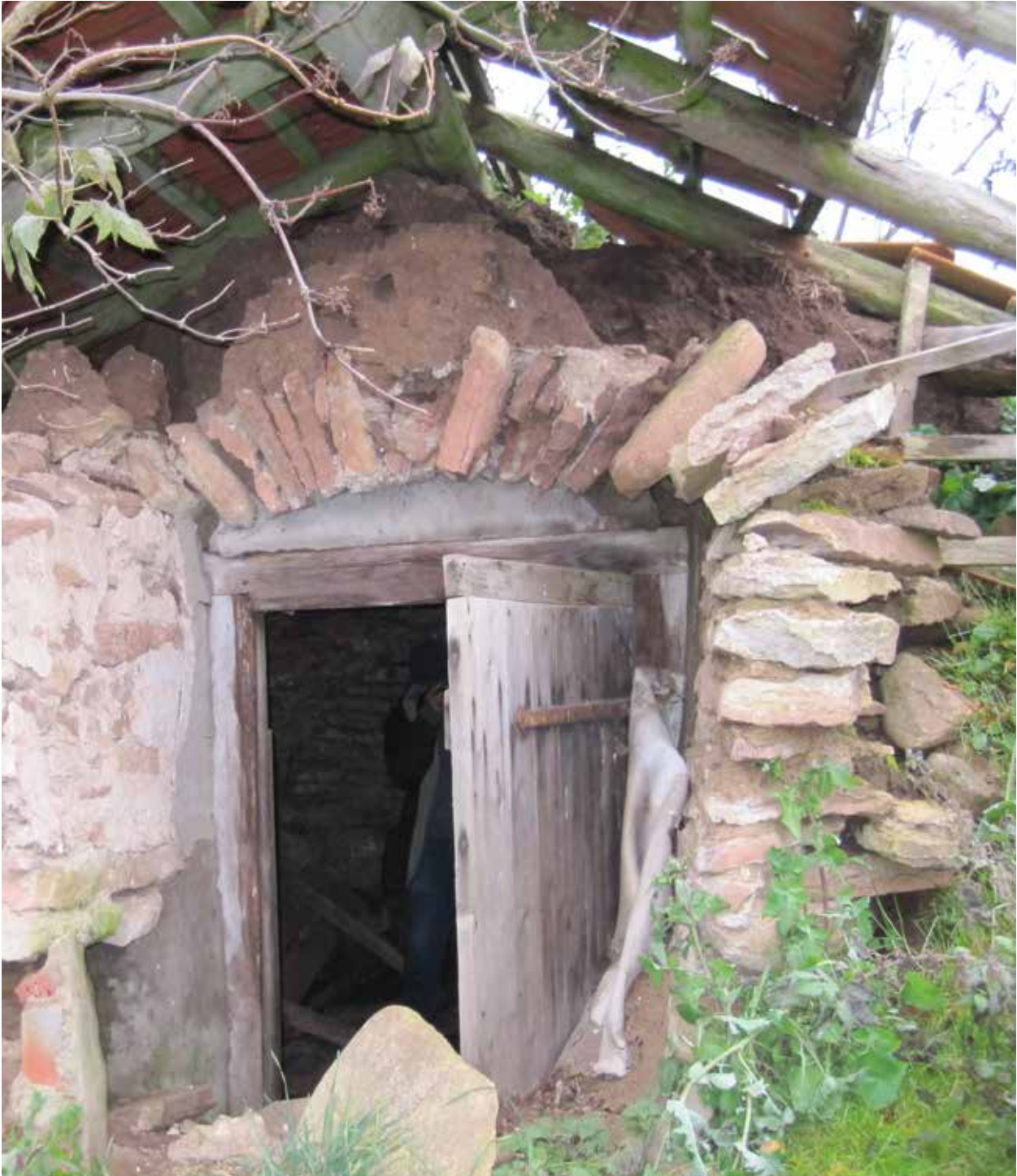
Jordkällaren i Gudhem före restaureringen började. Foto: Ann-Charlott Hajdu-Rafis
