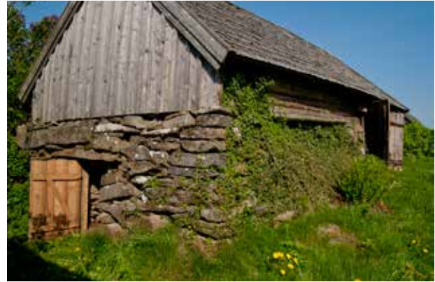
Frontmuren på jordkällare som är isolerad med en kärna av jordpackning. Äskhult, Halland. Foto: Bertil Lindgren
