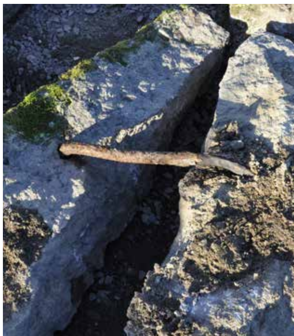
För att förstärka sidomurarna var de dubbade på insidan.
