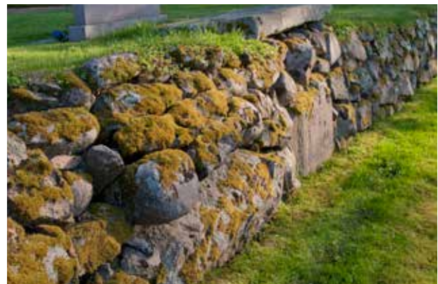
Stående långsgående nedgrävda stenar i botten-skiftet. Metoden är osäker och de vill gärna börja luta utåt med tiden. Holmestads kyrka, Götene, Västergötland. Foto: Bertil Lindgren
