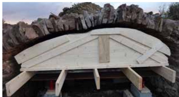
Valvbågen formades efter deformationerna.
