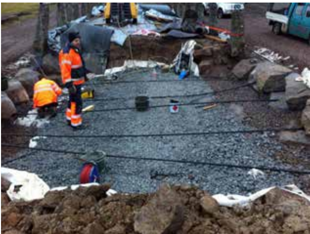
För att få bättre hållfasthet i sidomurarna ersattes järnkramlorna med dragstag. Foto: Anders Johansson
