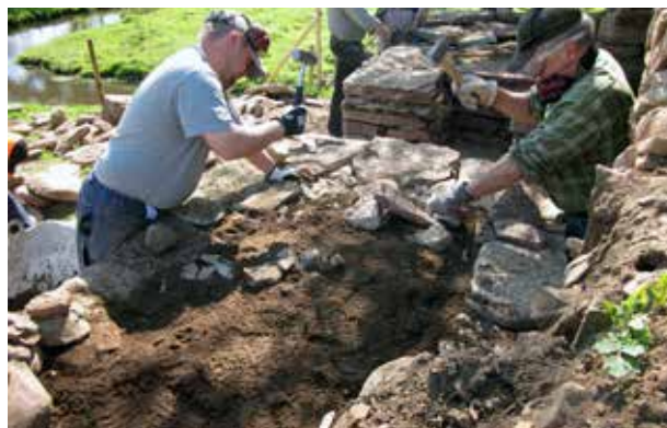
3. Småsten slås ner i jorden för att få den helt kompakt och stum. Det är bra att börja driva ner sten närmast muren, annars riskerar man att packningen spränger ut murstenen. Deltagare vid workshop.
