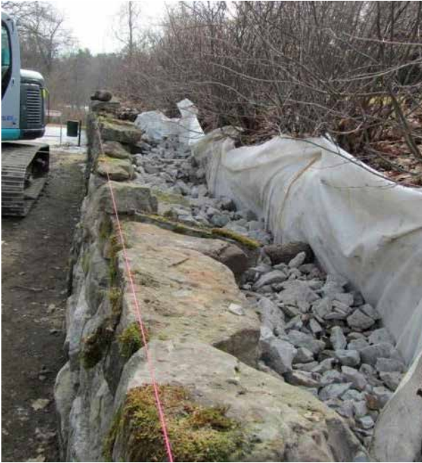
Muren snart uppe i färdig höjd. Foto: Charlott Torgén.
