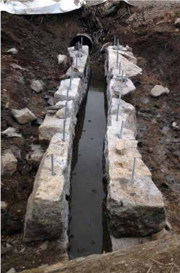
De nya dubbarna som ska förhindra att skadan kommer tillbaka. Foto: Anders Johansson
