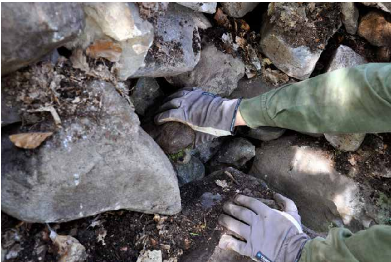
Skalmur med kärna av sten. Alla stenar läggs så att de bottenar och fyller ut alla hålrum. Foto: Börje Eriksson
