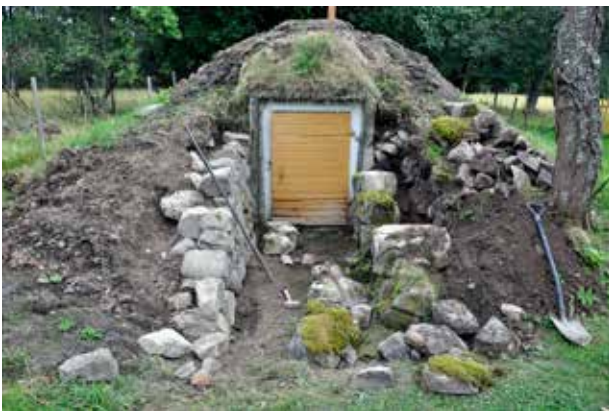
Restaurering av stödmur. Jordkällare i Ebbetorp, Mariestad, Västergötland.
