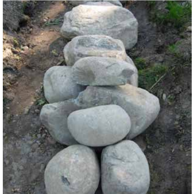
Två mindre stenar kan läggas i bredd om det är brist på tillräckligt stora bottenstenar. Mariagården Bohuslän.
