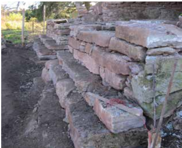
Murfot som förstärkning av grunden. Ambjörnstorp, Gudhem, Västergötland.
