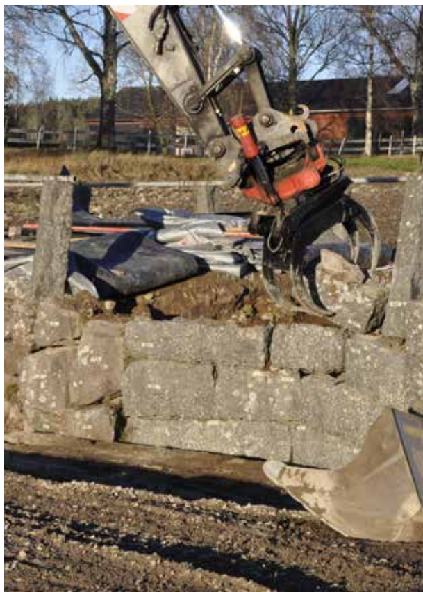
Grävmaskin med griplastare användes för att plocka ner sidomurarna.
