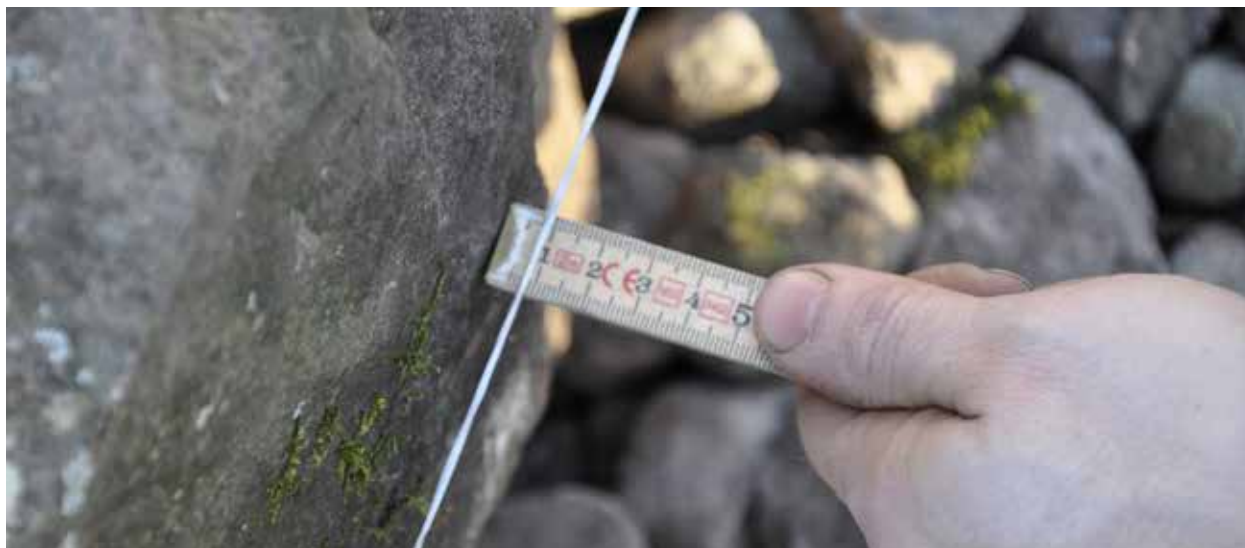
För att få en rak och fin murlinje läggs stenen efter en murarlina. Eftersom linan måste hänga helt fritt så mäter man ett bestämt mått in från linan. Foto: Cecilia Blomkvist
