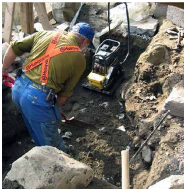
Kompaktering av befintlig jord med hjälp av padda och småsten. Foto: Espen Marthinsen
