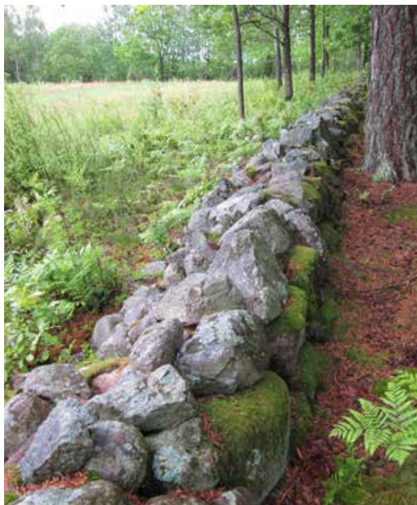
Halvmur med sten. Den murade sidan ligger mot betesmark, och stenskravlet mot åker. Kulturresevatet Åsnebyn i Dalsland.
