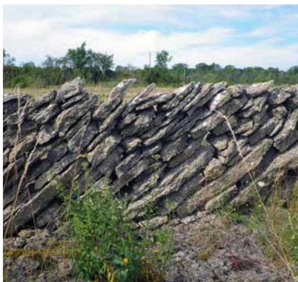
En lite udda enkelmur med helt snedställda kalkstenar. Norra Öland. Foto: Catarina Sjöberg.
