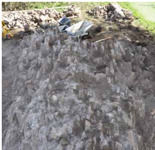
Det avtäckta valvet från ovasidan.
