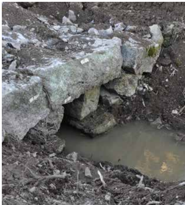
Inloppet till stentrumman under pågående demontering.
