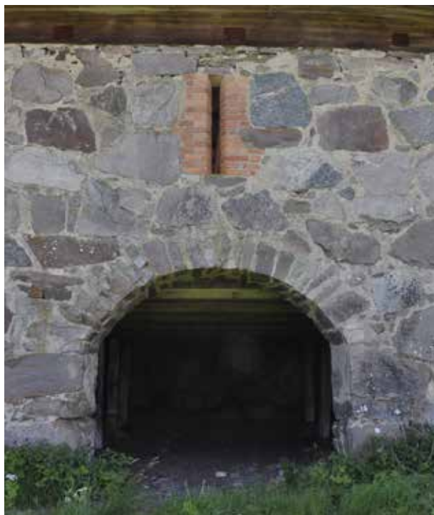
Öppning i väggen med valv. Jättadalen, Mariestad, Västergötland.
