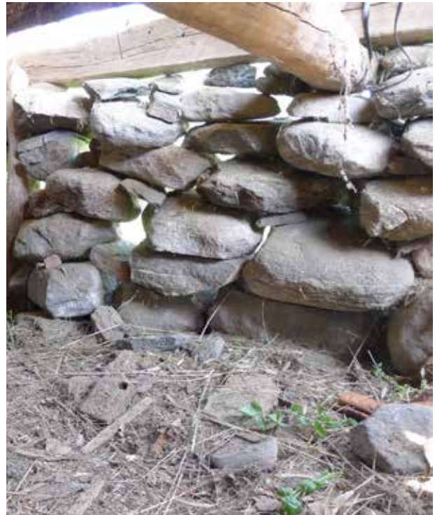
På insidan av grundmuren tas ingen hänsyn till om det blir slätt. Äskhult i Halland. Foto: Frank Karlsson.
