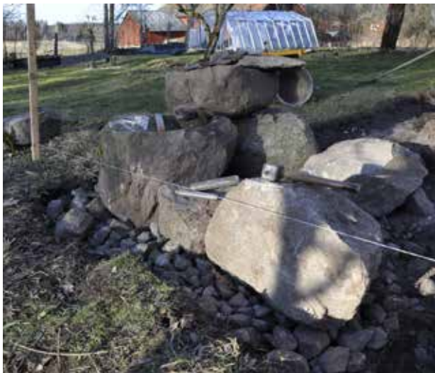
Bottenskiftet läggs med de största stenarna och riktas in efter murarlinan. Lassegården, Mariestad, Västergötland. Foto: Cecilia Blomkvist
