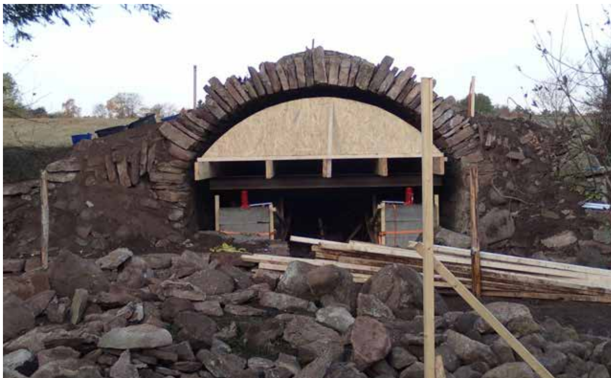
Valvställningen har sänkts ned och det nya valvet har låst sig. Foto: Espen Marthinsen
