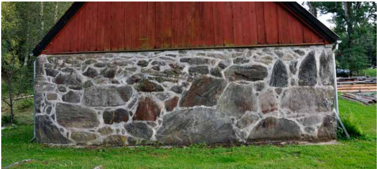
Uthusvägg med kärna av sten, fogad med kalkbruk. Örnans kulturresevat, Skåne.
