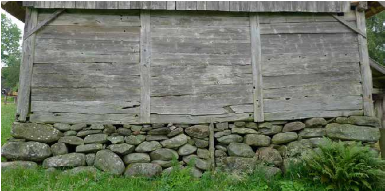
Skiftesverksbyggnad på kulturresevatet Äskhult i Halland. Hörnen som bär upp byggnaden har grundlagts med stora platta stenar. Den övriga enkelmuren är mer ojämn, men har en sida murad slätt. Foto: Frank Karlsson.
