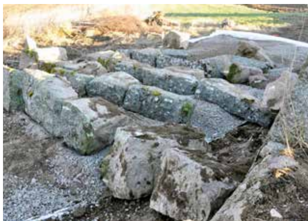
Numrering och sortering av mursten för att kunna montera tillbaka stenarna på samma plats. Vägersta, Askersund, Närke.
