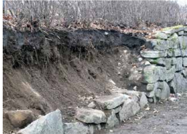
Muren demonterad, och den ursprungliga jordpackningen syns. Foto: Charlott Torgén.
