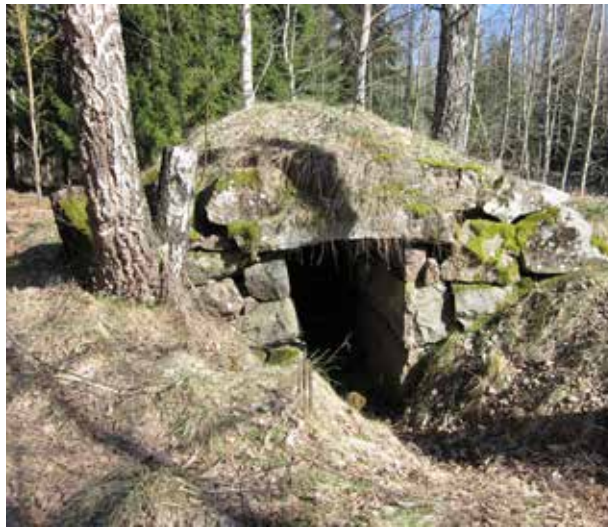
Jordkällare med balk som tak över svalen. Vallby, Skövde, Västergötland.
