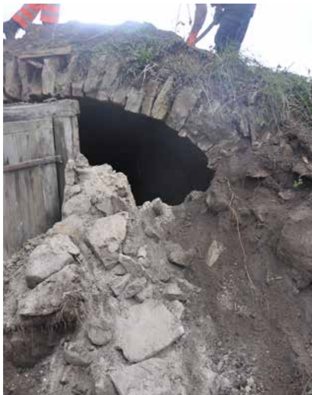
Frontmuren plockas ner och jorden på valvet tas bort.
