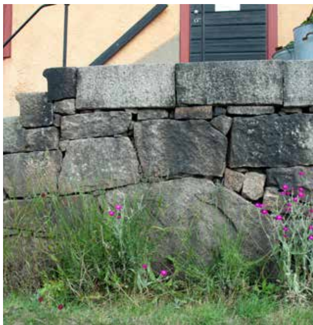
Hjälpstenar som lagts för att få de avslutande stenarna i rätt nivå, och utfyllare som fyller håligheter. Tjurkö, Karlskrona skärgård, Blekinge.
