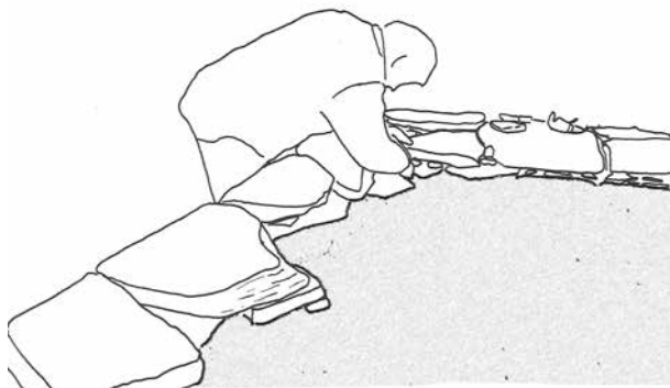
Kilning i bakkant av murstenen är ett viktigt moment i inpassningen av stenen.
