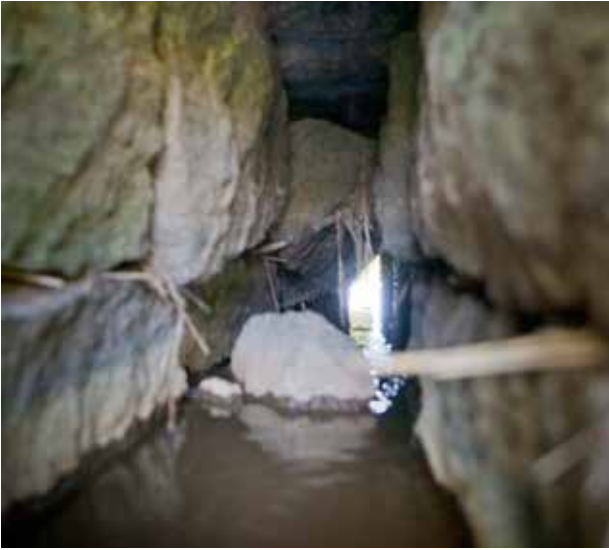
Den inrasade sidoväggen. Foto: Bertil Lindgren
