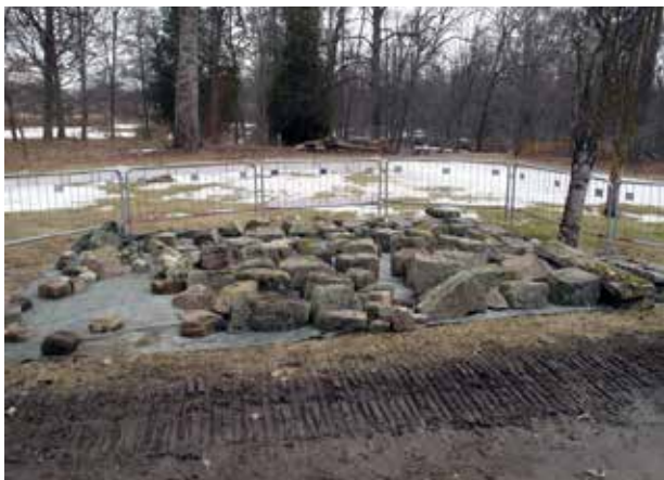
Murstenen spreds ut för att kunna se varje sten. Foto: Charlott Torgén.
