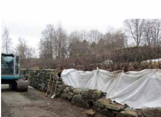
Muren demonterad, och geotextil utlagd. Foto: Charlott Torgén.
