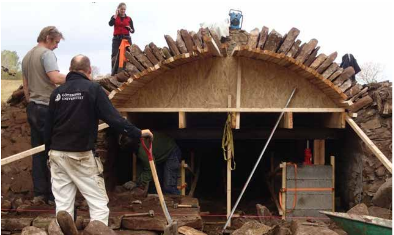
Det nya valvet under uppbyggnad. Foto: Espen Marthinsen
