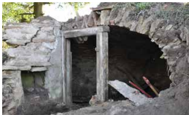
Frontmuren har plockats ner och kvar finns rester av svalen och dörrkar- men.
