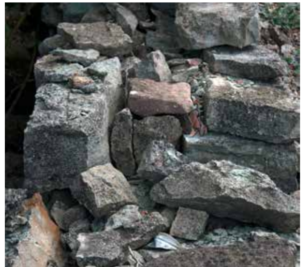
Skalmur med kärna av sten. Äleklinta, Öland.
