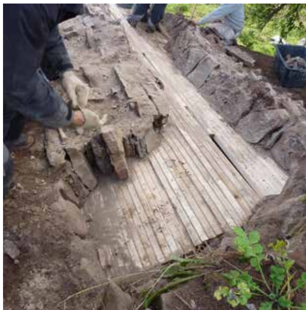
Skadade delar av valvet demonteras.
