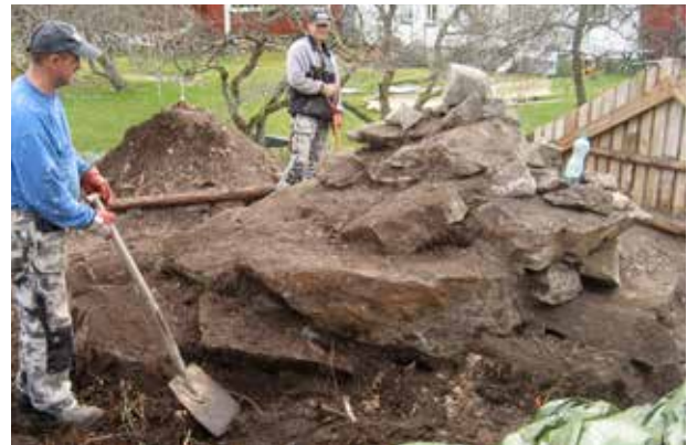
Jorden borttagen på en jordkällare av den runda typen. Hermanö, Bohuslän. Foto: Birthe Hellman.
