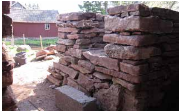
I svalen återskapas den nisch som återfanns i den ursprungliga muren.
