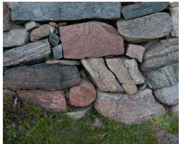
Stående stenar på höjden uppfattas av många murare som misspyrdande, kanske för att de skapar onödig instabilitet. Foto: Bertil Lindgren
