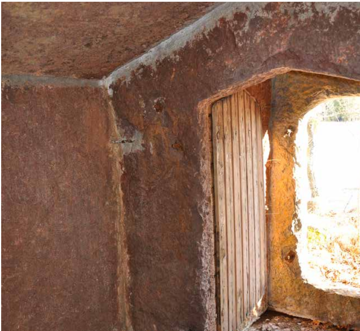
Jordkällare av förtillverkade kalkstenshällar - precis som ett pepparkakshus - sammanfogat med järnkramlor. Karleby, Mariestad, Västergötland.
