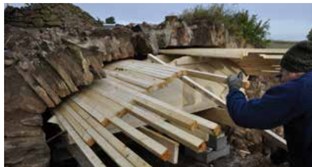
Skälbrädor skjuts på plats.
