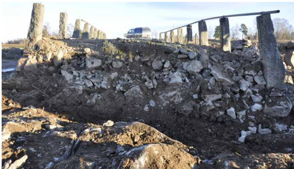
Vägfyllningen öster om trumman bestod av stenpackning
