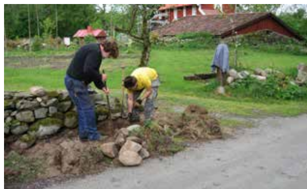
Restaurering av enkelmur.
