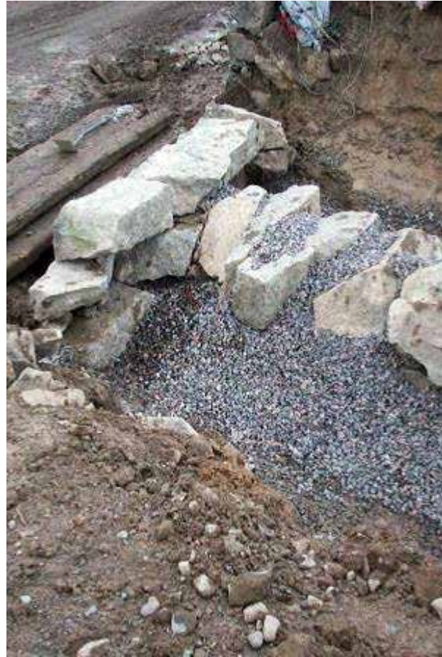
Balkarna har återmonterats över brotrumman. Foto: Anders Johansson
