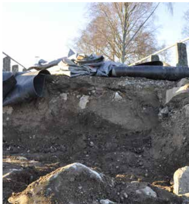
Vägfyllningen väster om trumman bestod av lera.
