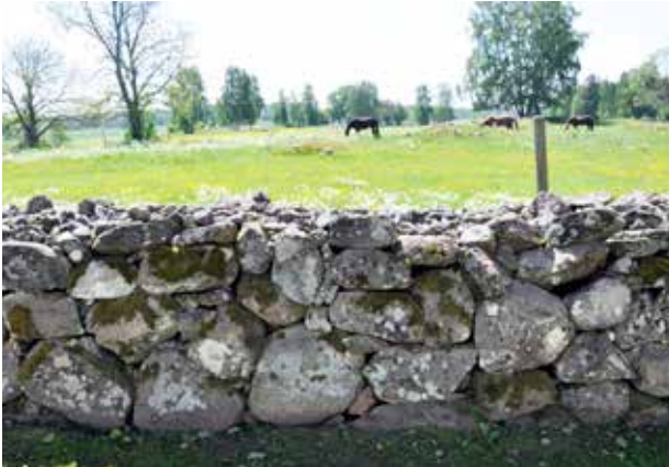
Kyrkogårdsmur byggd med fältsten (löst liggande sten). Berga, Mariestad, Västergötland.
