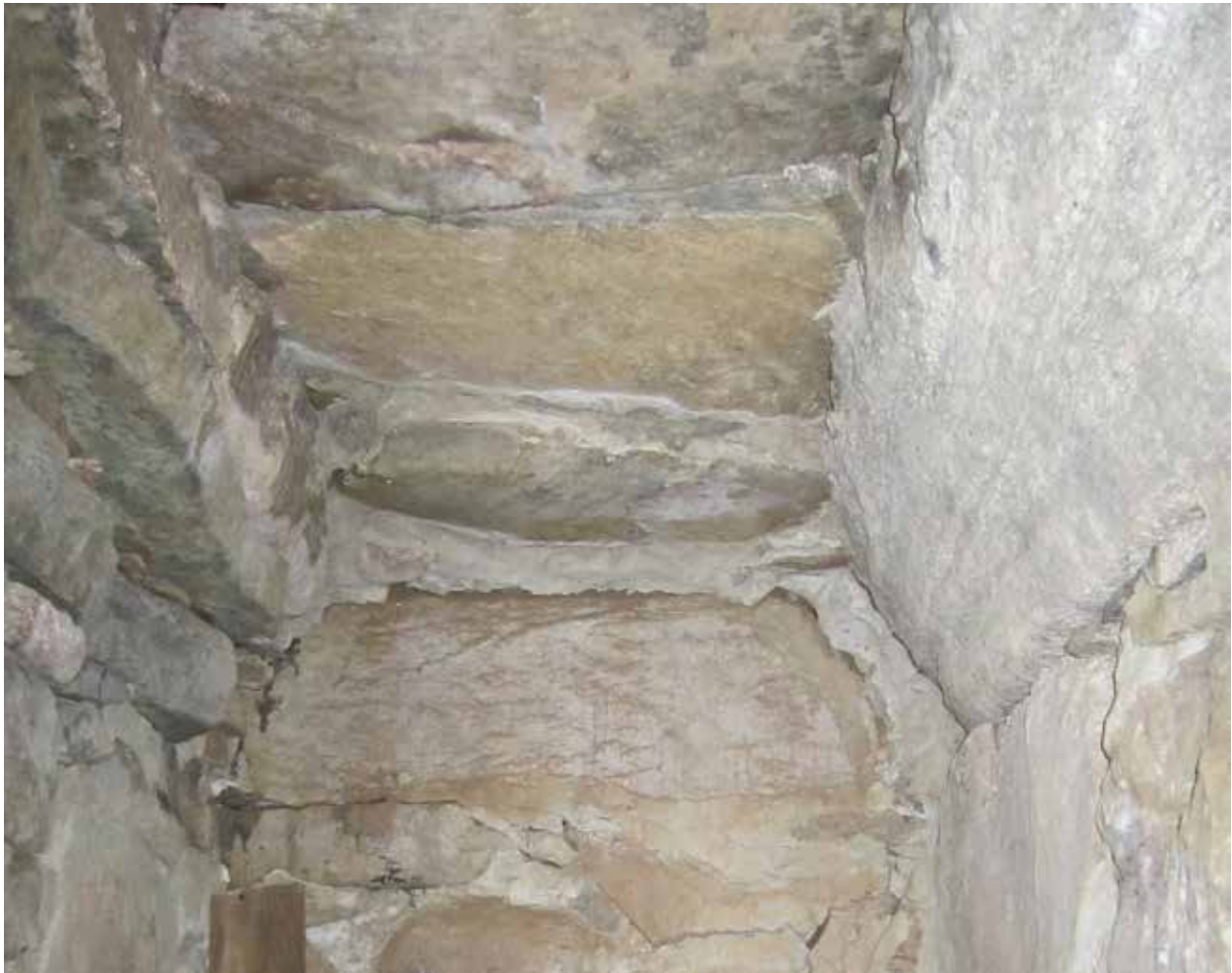
Jordkällare med s.k. hällatak. Väggarna smalnar av för att spannet ska bli så litet som möjligt. Enehögen, Floby, Falköping, Västergötland. Foto: Stig Johansson.
