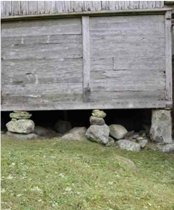
Ibland används endast enkla stempelare. Sporrakulla i Skåne.
