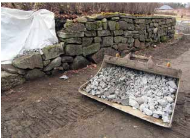
Skopa med den nya bakmurspackningen. Foto: Charlott Torgén.
