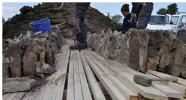
Valvbågarna har lyfts och valvet demonteras.
