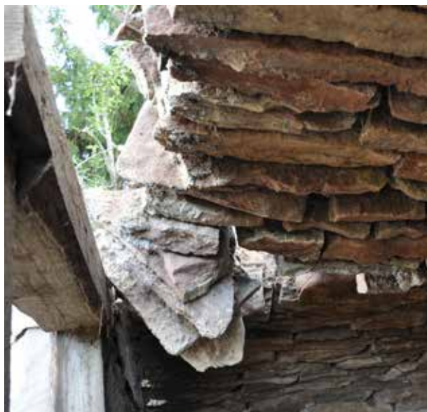
Valvet vilade delvis på dörrkarmen vilket gett upphov till skador.
