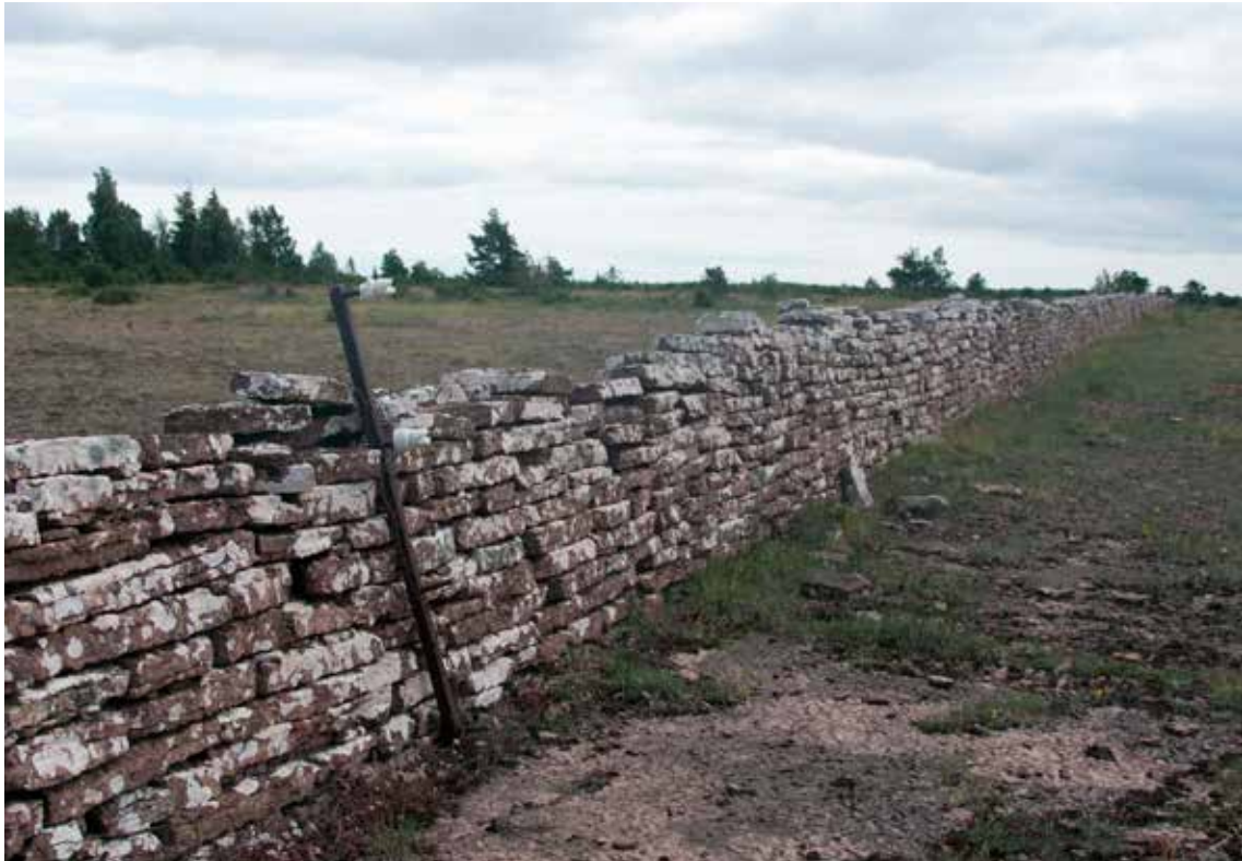
Enkelmur av kalksten med jämn skiftgång. Ölands alvar.
