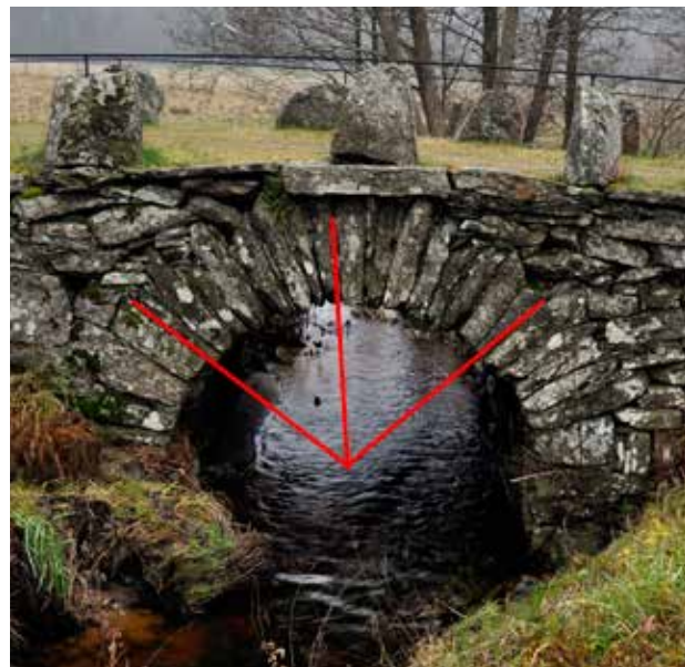
Fogarna är riktade mot brännpunkten.
