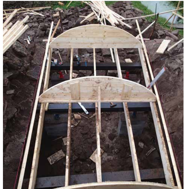
Den nya valvformen, efter att den misslyckade valvmurningen demonterats. Foto: Espen Marthinsen.
