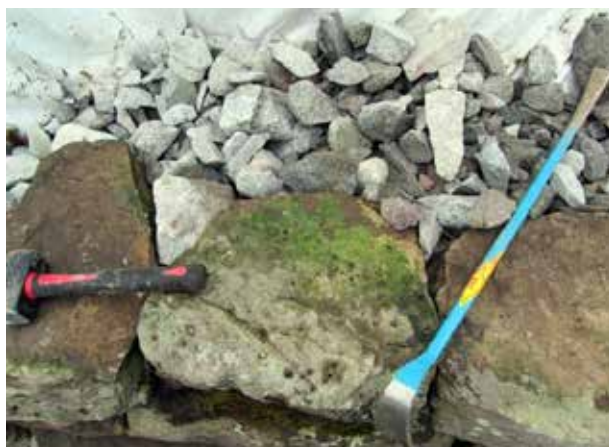
Verktyg som används vid murning. Foto: Charlott Torgén.
