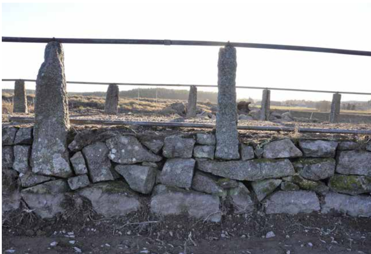
Stenstolparna var fästa med dubb eller järnkramlor.
