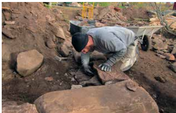
1. För att inte jordpackningen ska rinna ut täpps alla springor, fogar och hålrum till med småsten och kilar. Detta görs vid varje skift. Knut Steffen Knutsen, Kursledare vid workshop i Ambjörntorp, Gudhem, Västergötland.
