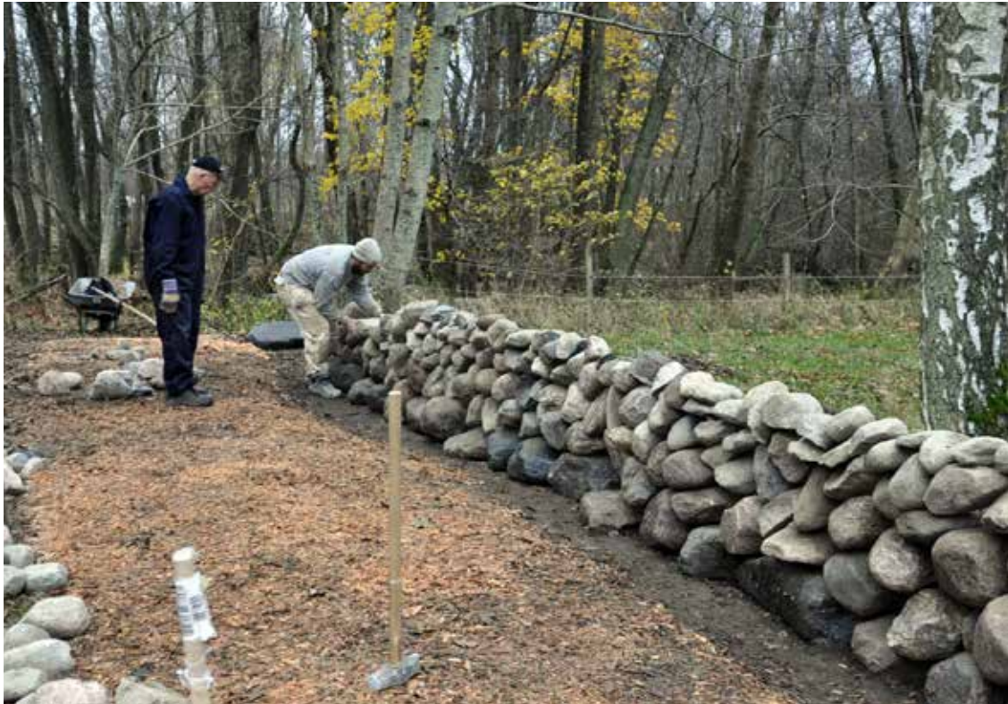
Knut Steffen Knutsen lägger enkelmur med ojämn skiftgång under övervakning av Evert Gustavsson. Mariagården Bohuslän.
