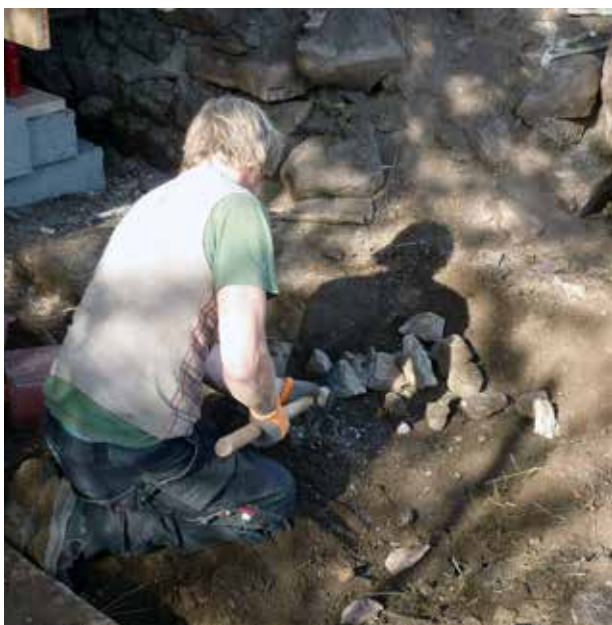
Espen Marthinsen kompakterar befintlig jord med slägga och småsten. Ambjörntorp, Gudhem, Västergötland. Foto: Pontus Carlsson
