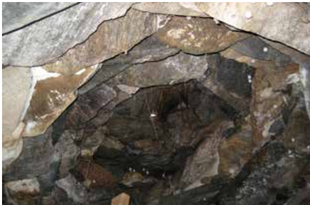
Den runda överkragningen som blir toppig och hög i formen. Mindre sten kan användas. Hermanö, Bohuslän. Foto: Birthe Hellman.
