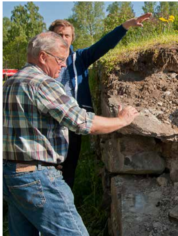
Espen Marthinsen och Christer Börjesson diskuterar skador på en stödmur utanför Örebro. Foto: Bertil Lindgren.
