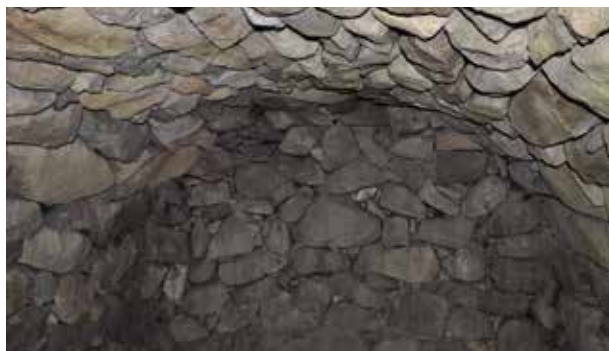
Bakmuren på en jordkällare är konstruerad som stödmur. Sporrakulla, Skåne.
