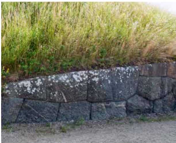
Stödmur fortifikationsverket, Blekinge.
