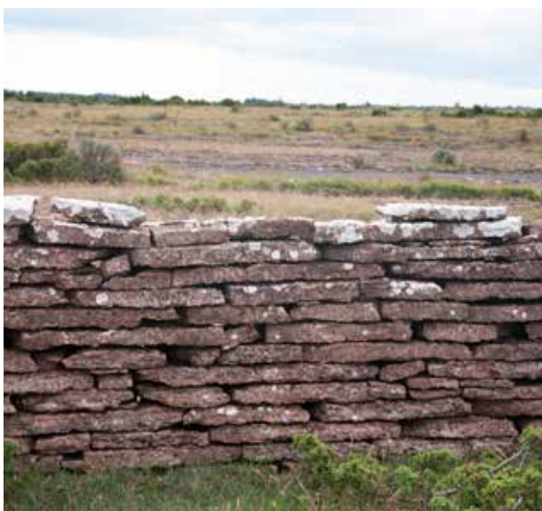
Enkelmur av kalksten på Ölands alvar.
