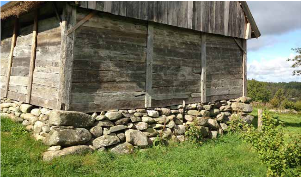
Jönsas ladugård efter restaurering av både träkonstruktion och stenfoot.
