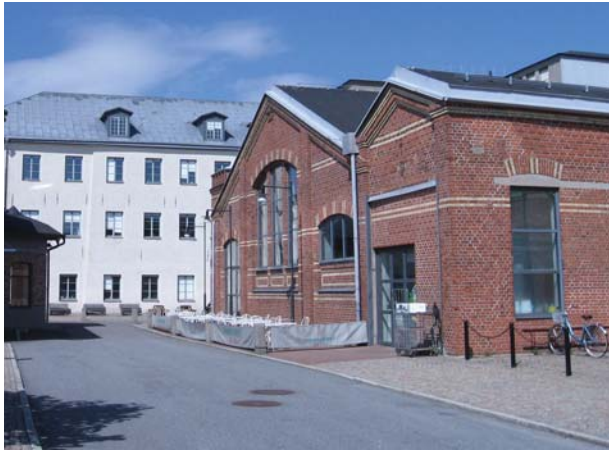
Gamlestadens fabriker, f.d. Sockerbruket vid Änäs och pannhus. (Foto: Modin/Söderback.)
