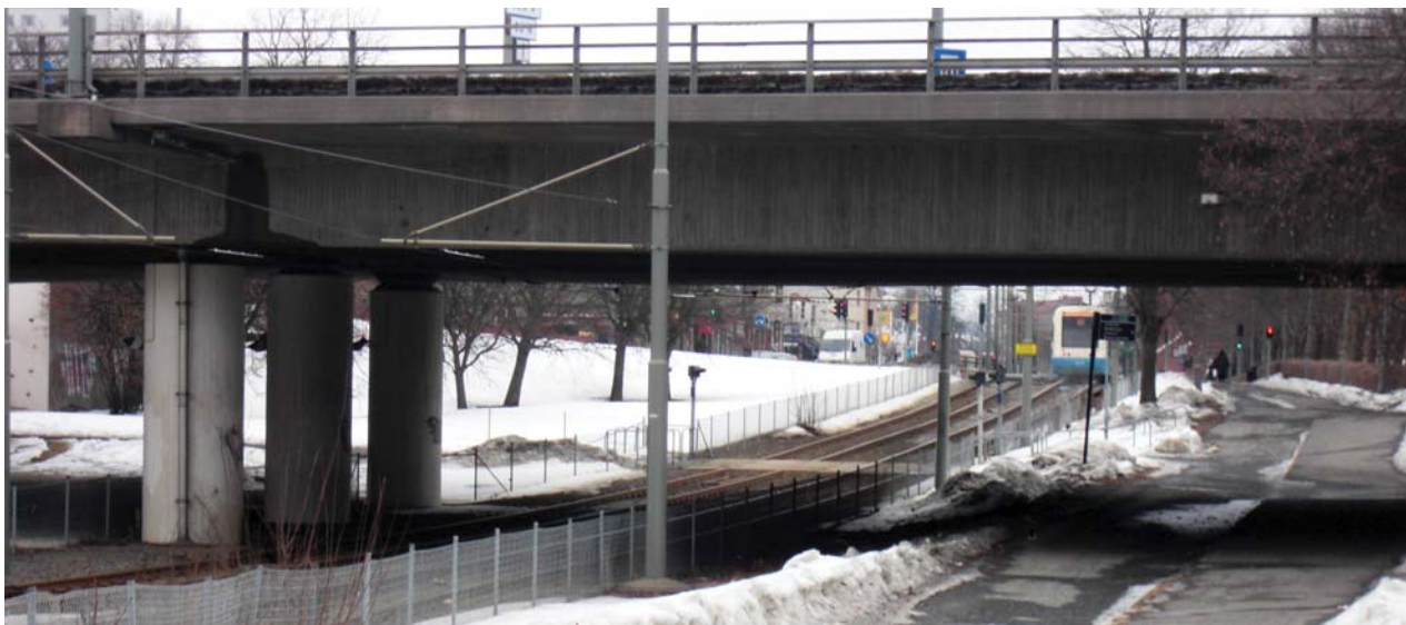
Vägiadukten över Gamlestadsstorget. (Foto: Martin Gren.)
