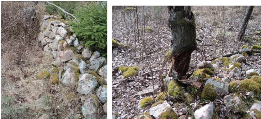
Figur 14 t.v. Föreställer övergången från dubbelmur till halvmur i mur 1A Figur 15 t.h. visar en tagträdsrulle vilket är invallad i ett träd
