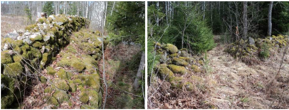
Figur 16 t.v. Visar terrasseringen i muren mot barrskogen Figur 17 t.h. Visar öppningen mellan murarna 2A och 2B
