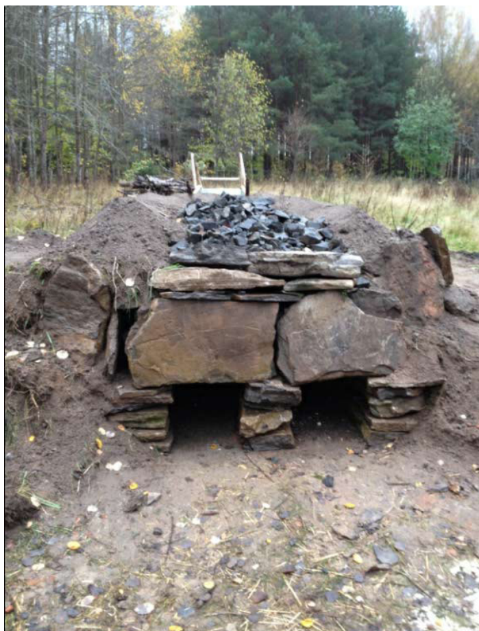
Figur 3. Pågående byggnad av en fältugn i kursen murteknik 1 vid Göteborgs universitet. Foto. Jolina Ånstrand (2014)
