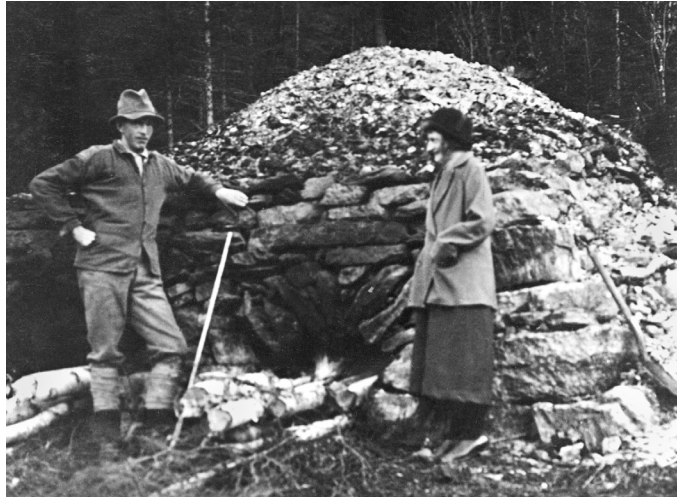
Figur 4. Fältugn med murat valv. Foto: Valter Strömberg/Jamtis fotosamlingar
