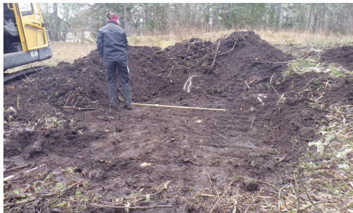
Figur 8. Uppmätning av urgröpningen. Foto Erik Bergholtz
