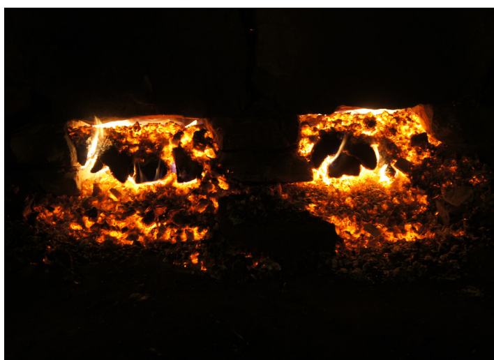
Figur 38. Ny ved har lagts in i eldstadsöppningarna och glöd har skjuffats upp på veden för att förvärma luften som kommer in i ugnen.
