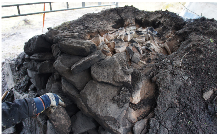
Figur 41. Skyddsmuren plockas bort. Man ser hur kalkstenen har vitnat och det översta lagret sten är svart av sot.
