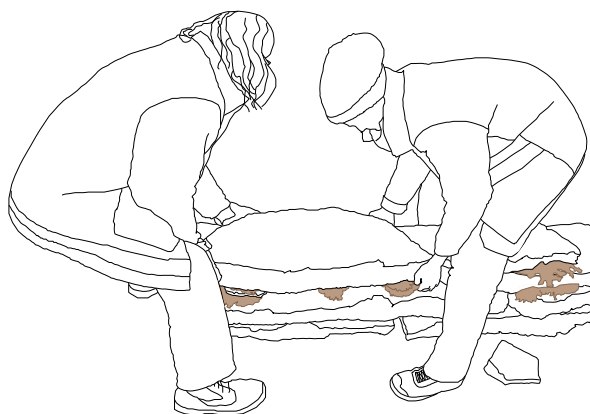
Figur 15. Stenen lyfts upp och trycks till så den ligger stabilt.
