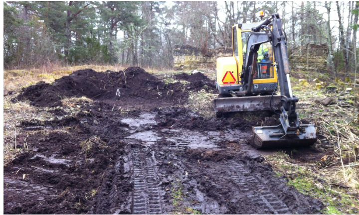
Figur 7. Påbörjad urschaktning. Under några lager jord är det enligt ägaren berggrund och en gammal väg.
