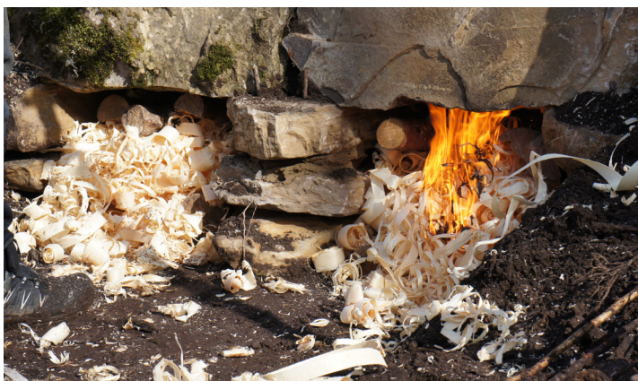
Figur 31. Den bögra eldkanalen har nu tänts på och hyvelspånen fattar snabbt eld.. Inne i kanalerna har halva kanalhöjden fyllts med 50 cm ved varvat med hyvelspån.
