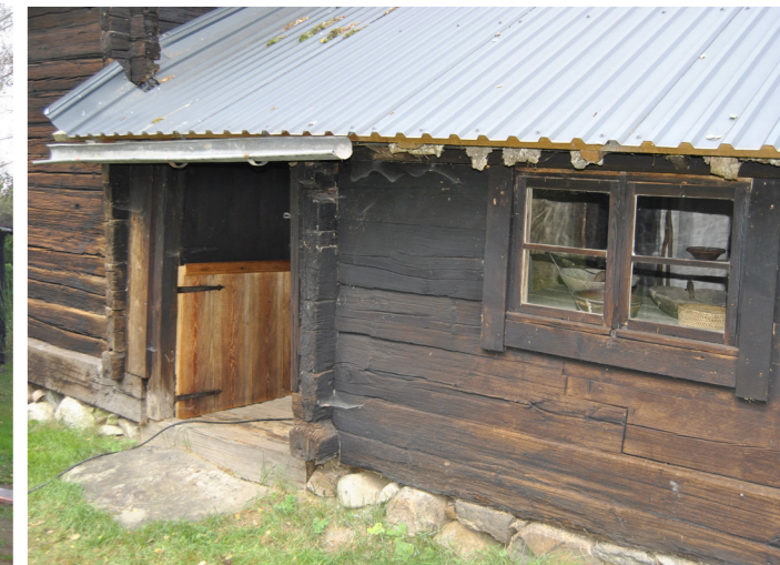
Figur 7.28. Stugan vid knut AD, vilket är den knut som finns uppmätt på sidan 217.
