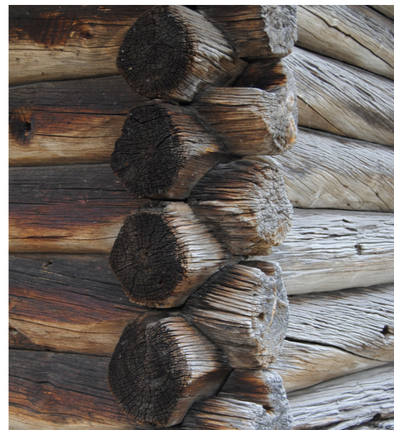
Figur 7.23. De knutar som mättes upp är i de undre varven i knuten till höger om dörren, d v s knut AD. Av bilderna framgår hur välbevarad hela byggnaden är och knutarna är i det närmaste helt intakta. Det gäller även för knutarna som inte skyddas av framsidans tak. Underfasningarna är mycket tydliga och går helt ut till skallens ände. Stockarna har inga överfasningar annat än ute på knutskallen som täljts till en ganska tydligt och symmetrisk sexkantform.
