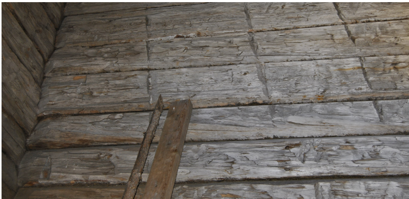
Figur 7.14. "Salsdelen" av byggnaden blev aldrig färdigställd. Här syns hur inhuggen i stockarna följer ovanför varandra och är gjorda på plats för det antal stockar som bör motsvaras av ett bomlag. (Men vi fann inga spår av invändig ställning av den typ som har borrats in i väggen med grova navare.) Att stockarna ovanför är finare bilade är också en normal del i arbetsprocessen så som den beskrivs i uppteckningar: man finbilar färdigt de tre-fyra översta varven innan man lägger tak annars kommer detta att bli onödigt trångt och arbetsamt att bila till en fin yta.
