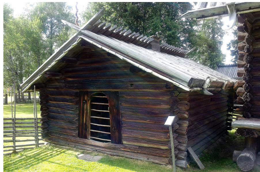
Figur 1.1. Eldhuset från Noret står idag på Zorns gammalgård i Mora. Huset är en av Sveriges äldsta profana byggnader och det är daterat till 1230-talet. Foto: Wikimedia Commons, se nedan. ©
