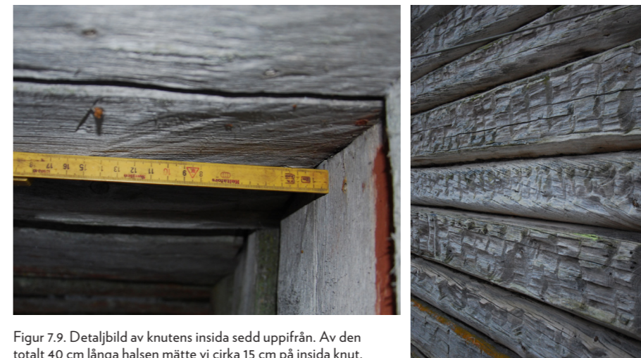
Figur 7.10. En gavelvägg på den äldsta byggnaden i Gallejaur, ett stall från 1830-talet. Väggen är bara förberedd för bilning genom inhugg, grovkläckning, som sitter så tätt att mycket virke avverkats innan själva bilningen skulle påbörjas. Väggen har varit placerad mot en annan byggnad och därför blev det inte nödvändigt att finbila för att förbättra skyddet mot regn och fukt.
