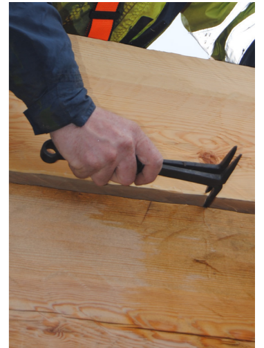
Figur 2.12. Den undre stockens form förs över på den övre stocken. Bilden visar sydsvensk timring som inte har någon såt när stockarna timrats ihop.
