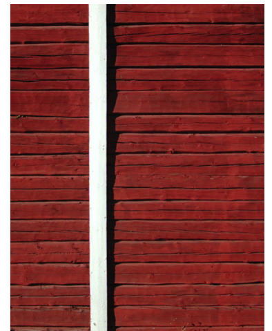
Figur 2.20. Samma fasad som ovan. Väggen vetter nu mot byvägen men var tidigare en "bakkvägg", entrén låg på motsatta sidan. Här kan man se, trots att man troligtvis har haft möjlighet på en bondgård före de stora dimensionshuggningarna på trakten att välja mer optimalt virke, att det inte blivit fallet. Det är stor skillnad emellan rot och topp, det är relativt klen virke med en hel del kvist. Kvistbulor är inte särskilt noggrant bearbetade och draget skiftar mycket i bredd.
