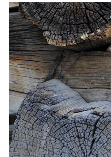
Figur 7.24. Falsen i stock A2 vid knuten AB. Falsen hindrar den undre stocken B1 från att glida utåt. Samma iakttagelser gjordes i stocken ovanför dörröppningen där den har haft samma låsande funktion. Falsen fanns även i A-väggens stock ovanför dörren i ett annat, liknande härbre på hembygdsgrden.
