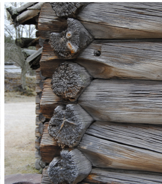
Figur 7.23. De knutar som mättes upp är i de undre varven i knuten till höger om dörren, d v s knut AD. Av bilderna framgår hur välbevarad hela byggnaden är och knutarna är i det närmaste helt intakta. Det gäller även för knutarna som inte skyddas av framsidans tak. Underfasningarna är mycket tydliga och går helt ut till skallens ände. Stockarna har inga överfasningar annat än ute på knutskallen som täljts till en ganska tydligt och symmetrisk sexkantform.
