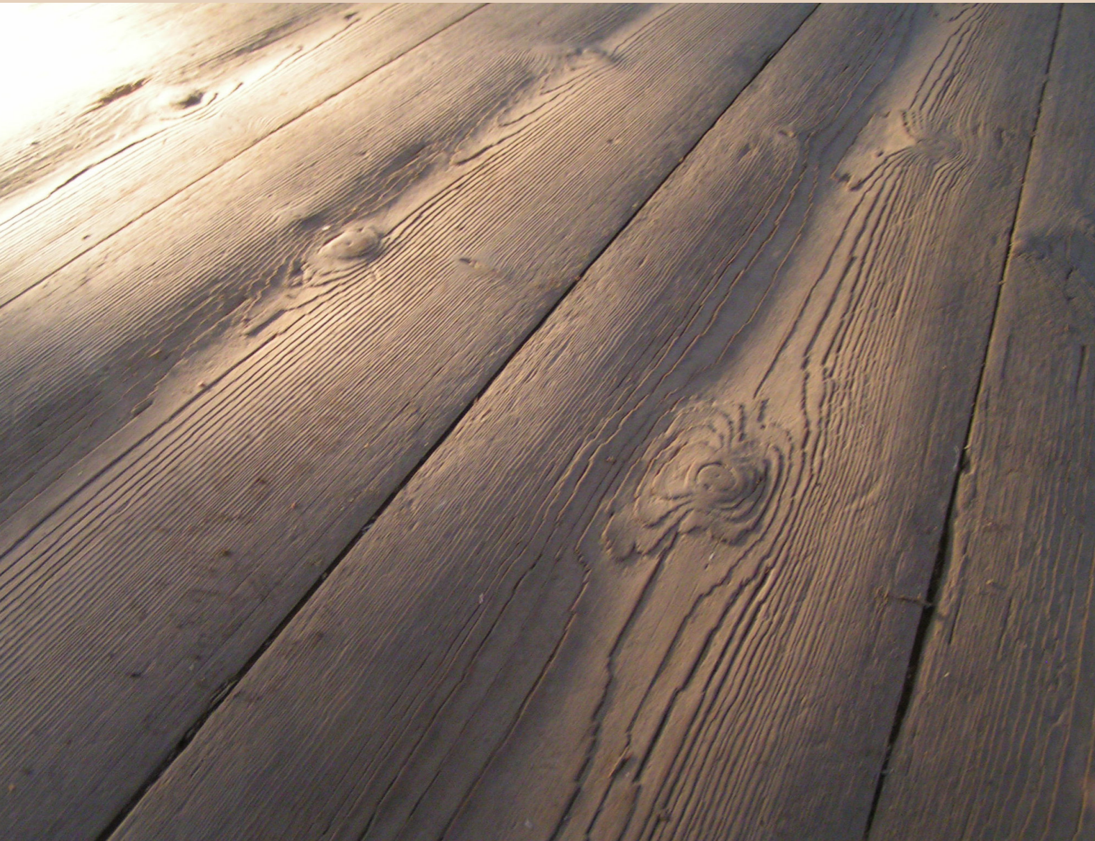
Dubbat och kanthyvlat golv från bostadshuset på Örnanäs, Örkeneds socken, Skåne. Foto: Gunnar Almevik.
