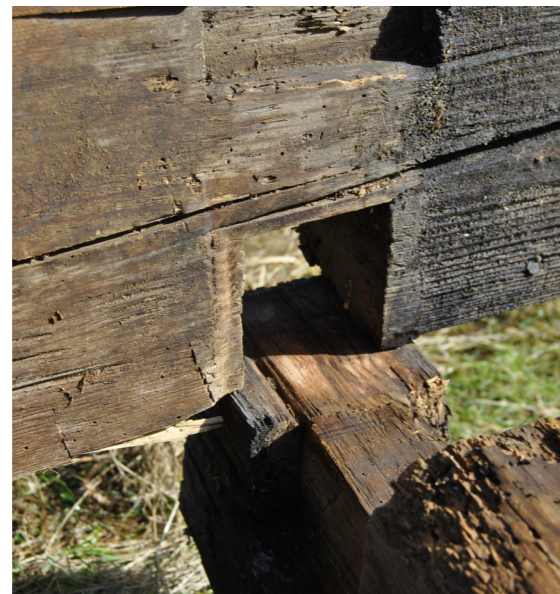
Figur 7.26. Tre foton av Östra härbergets knut. Vid undersökningen var huset nedplockat. Den högra bilden visar dock knutkedjan uppmärkt inför demontering.
