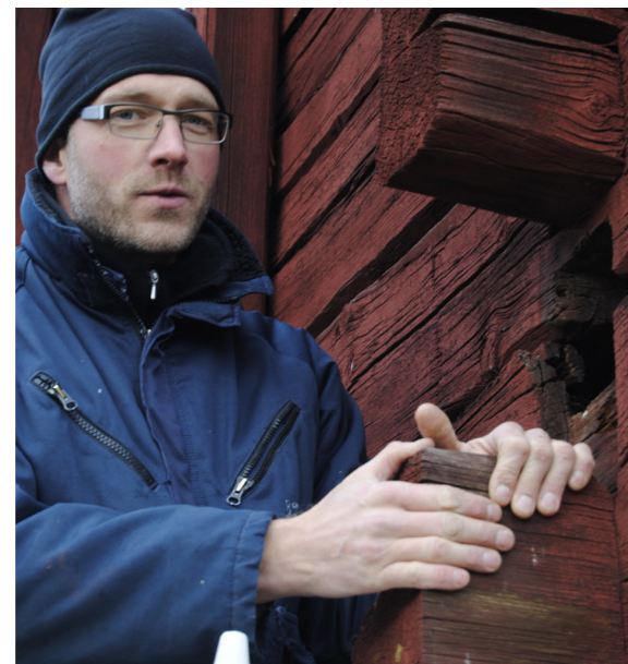
Figur 7.17. Rak halvhaksknut representerar en vanligt förekommande knut i övre Norrland.
