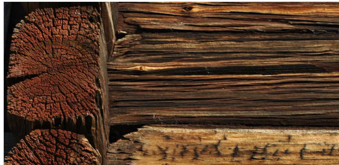
Figur 7.15. Till höger om knutkedjan (BC-knuten i det undersöka huset) ser man små "trianglar" där virket är borthugget. Den här typen av hål, rakt in i rummet innanför, är vanligt i området och kan många gånger vara betydligt större.
