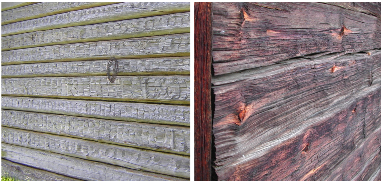
Figur 2.7 till vänster. Den här gaveln har kvar den grovbilade ytan som aldrig kom att finbilas. Idag är gaveln en yttervägg. Från början var den inte synlig utan stod vänd mot en foderlada. Ladugård från 1830-talet i byn Gallejaur.
