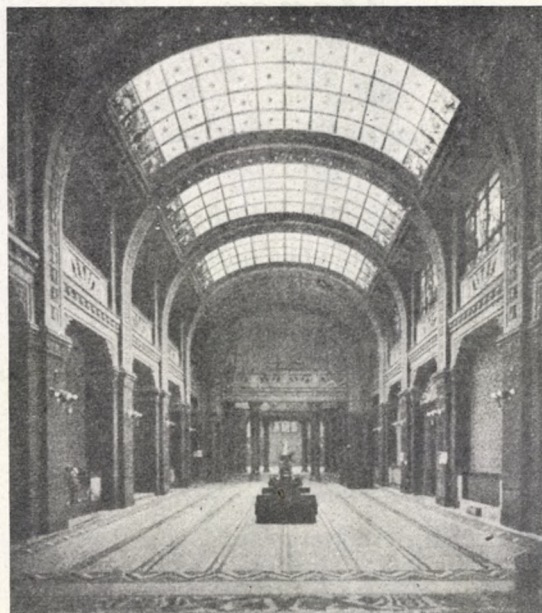
Stora vänthallen i badhuset.
