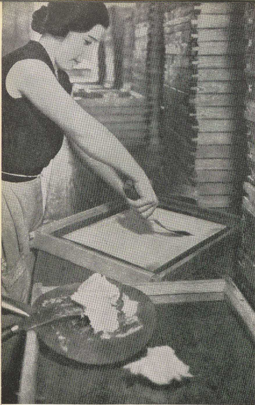
En fransyska och hennes familj. Mannen är gruvarbetare och själv är hon arbeterska på en parfymfabrik. Bilden visar hur växtdelarna inbäddas i fett varigenom de ömtåligaste luktämnen tillvaratagas.
