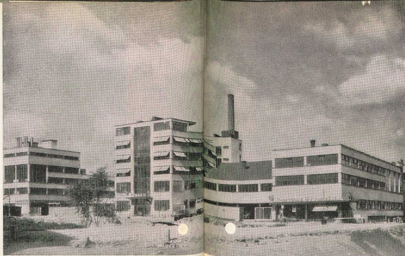
Det nya konsumhuset vid Södra Bantorget i Stockholm redan berömt för sin stilrena och rationella arkitektur.
