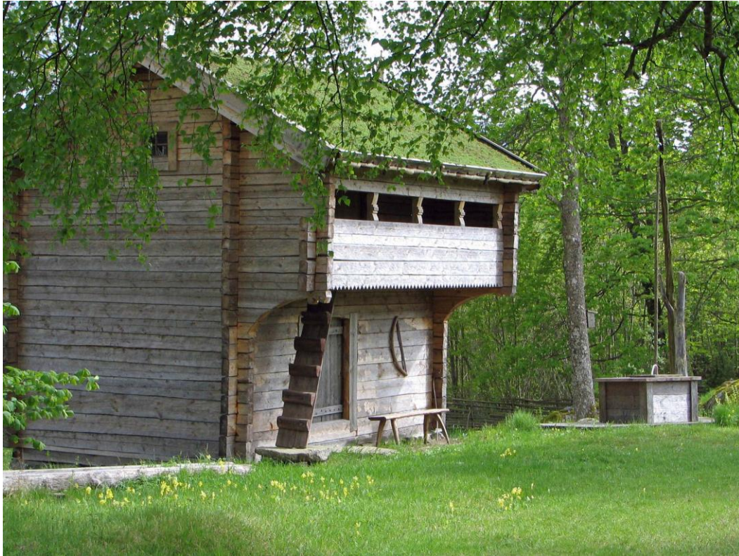
Fig 14. Loftbod, Kroksjö, Madesjö socken, Småland. Svalgången är byggd på de utskjutande golvbjälkarna respektive gavelstockarna. (P. Melin)
