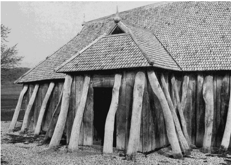
Fig. 1. Rekonstruktion av ett av de vikingatida husen i Fyrkat, på norra Jylland. Taket vilar på väggarnas resvirke. Plankorna är nedgrävda och stabiliseras av snedsträvor. Husets längd 28,5 meter och största bredd 7,4 meter. (Henriksson 1995:20).
