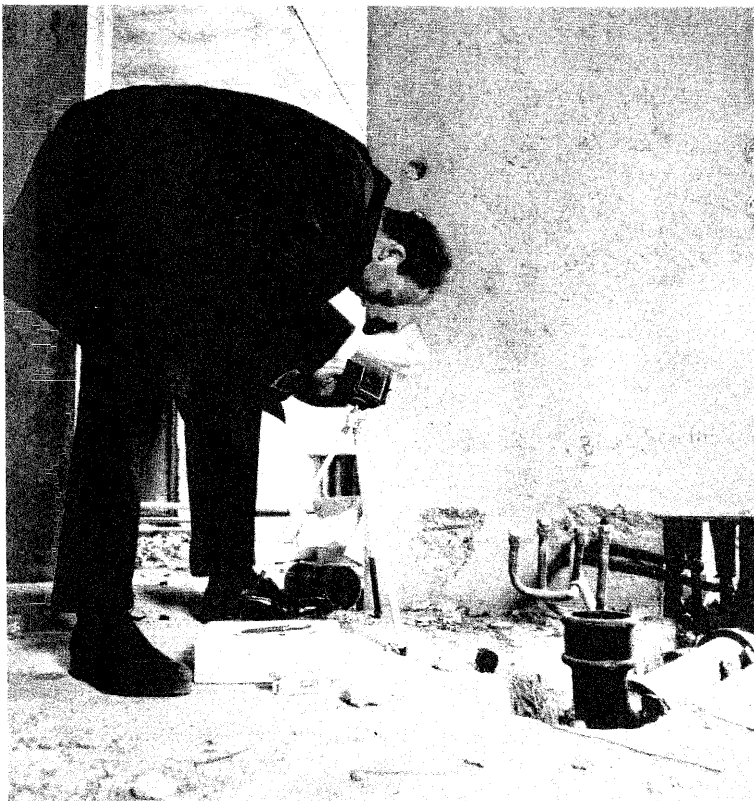
Installationerna utgjorde under 60-talet en femtedel av byggkostnaderna. Byggandet fördröjades även om man byggde med stomelement. På bilden visas problemet mismatch mellan förtillverkat element och rördragning – håltagningen hade glömts bort. Foto Hans Malmberg. Från skriften Byggnadsforskningen utgiven av SIB 1966.
