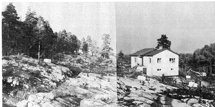
FIG. 1 Försökshuset av lättbetong i Älta utanför Stockholm
