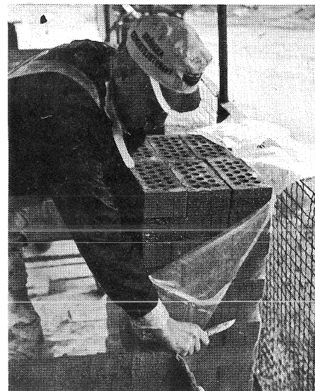
FIG. 2. Öppning av krympfilmsemballage.
