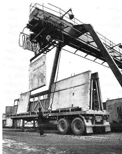
FIG. 3. Lastning av element vid fabrik.
