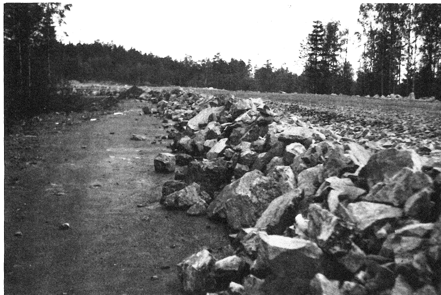
FIG. 1. Sprängstensbank av s.k. mellanbyggnadstyp för ett pågående vägbygge.
