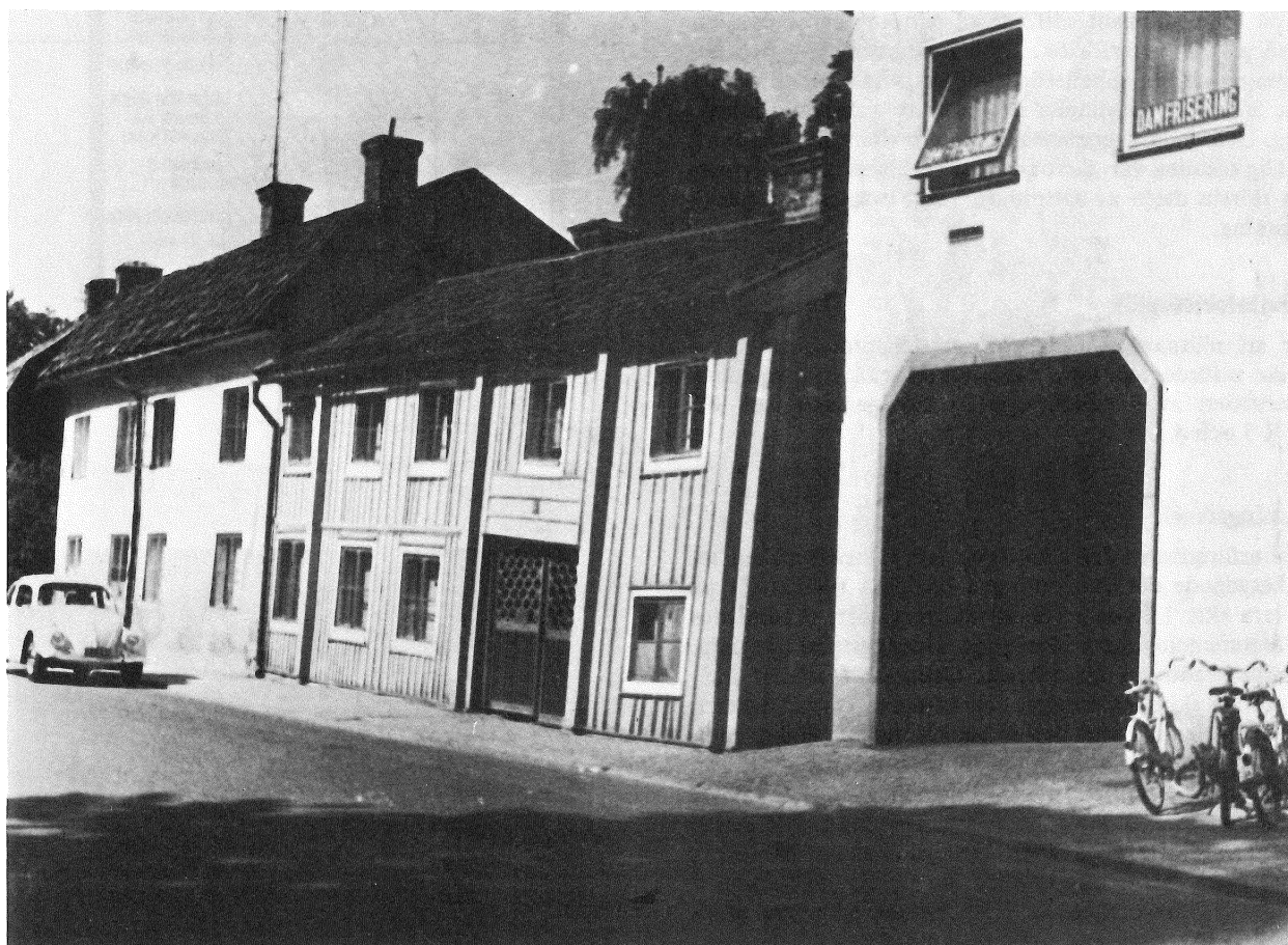
Byggnader får ofta utan synbara skador eller sprickor sådan lutning att de från estetisk synpunkt ser otillfredsställande ut. Bilden visar ett fall från Köping.
