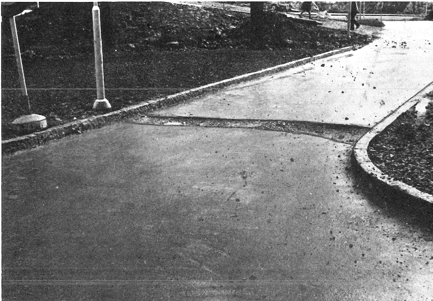
Fig. 2. Läggning av elledningar igångsätts ofta på ett för sent stadium och efter själva gatuarbetena.
