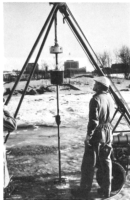
Frifallshejarutrustning är ett komplement till den vanligen använda hejarbocken. På bilden har gripanordningen just släppt hejaren.
