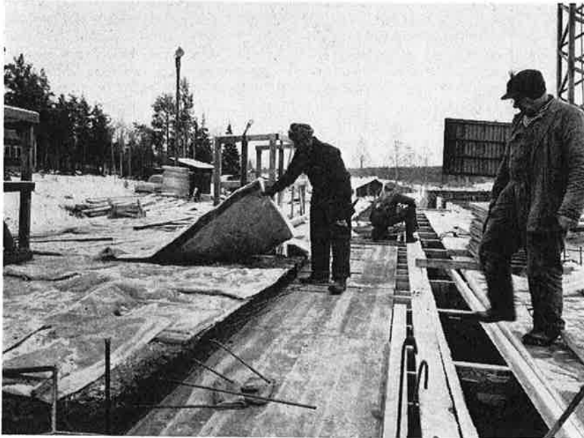
En god täckning av nygjutna bjälklag höjer starkt effekten vid värmning med byggtorkar.
