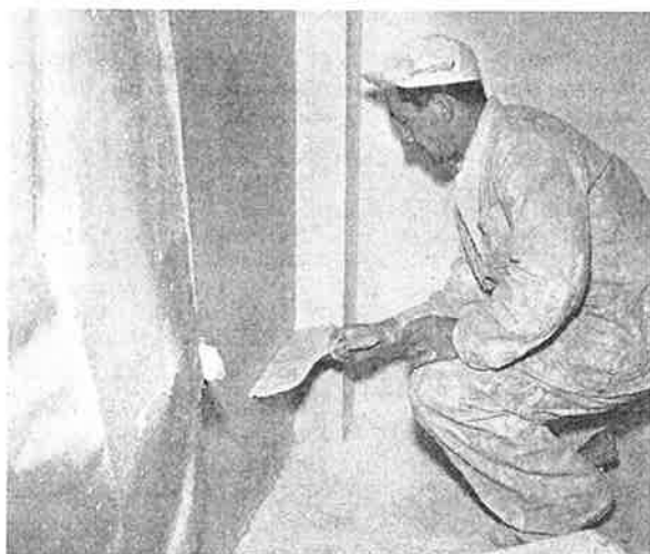
Nedan: Bild 9. Slätning av bredsprutat vägg
