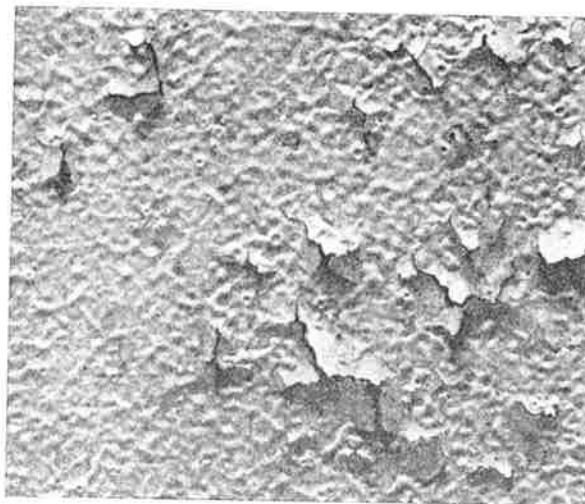
Nedan: Bild 12. Förtvålningsskador på oljefärgsmålade kökstak
