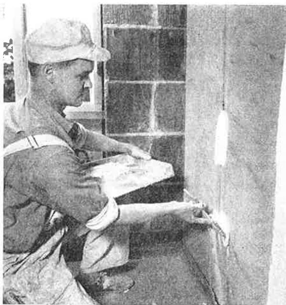
Ovan: Bild 4. Skarvspackling av lättbetongplank
