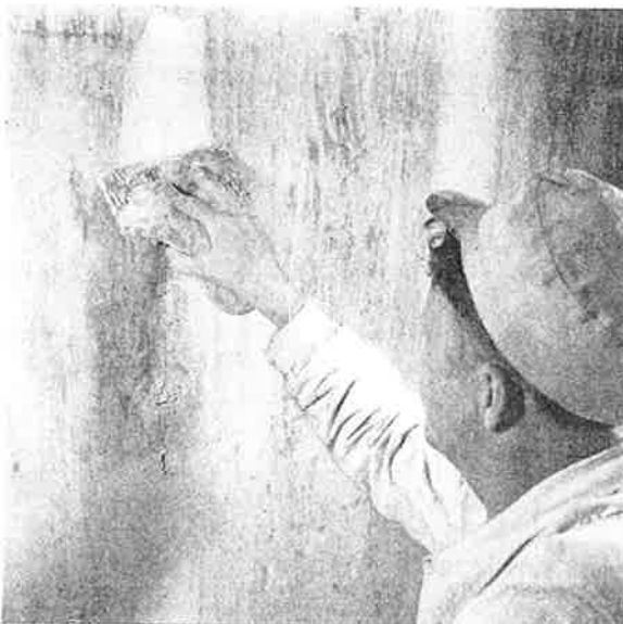
Ovan: Bild 5. Skarvspackling av betongvägg
