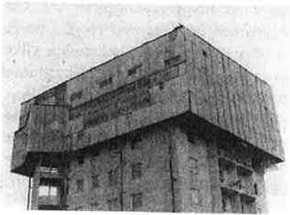
Fig. 8. Fabrikshall av stålprofiler på tiövånings elementbygge i Västerås 1957-1958 (Västerås Fackföreningars Byggnadsproduktion).
