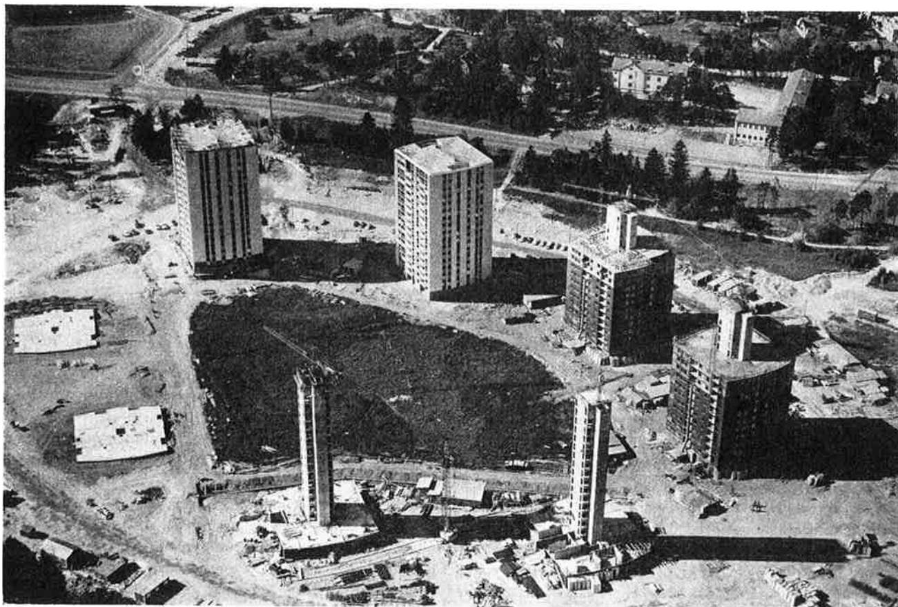
Fig. 3. Skarnes lätta system tillämpat på åtta punkthus i 16 våningar i Näsbydal utanför Stockholm.
