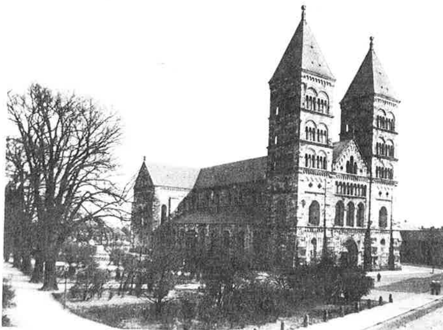
Det svenska 1800-talets största och kanske också mest intressanta restaureringsföretag var omdaning av Lunds domkyrka. Arbetet inleddes redan 1833, men inte förrän Helgo Zettervall lagt fram sina ritningar 1863–64 fick restaureringen sin medvetna och storstilade karaktär, kyrkan skulle återföras till ett utseende den visserligen aldrig haft, men som ändå tänktes motsvara 1100-talets – grundläggningstidens – intentioner. – Västtornen före, under restaurering och efter arbetets avslutande.
