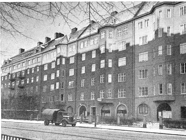
Fig. 5. Kv. Kakelugnen, Stockholm. Bilden visar några hus som byggdes omkring år 1913 med den tidens karakteristiska burspråk.
