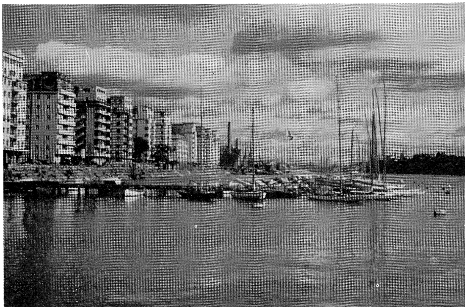
Norr Mälarstrands västra del, bebyggd 1930—32, 8 våningars bostadshus med stomme av armerad betong isolerad med lättbetong. Foto G. Lundh, STF:s bildarkiv.
