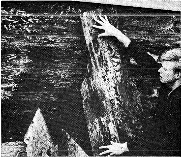
Fig. 9. Kondensation på innervägg med åtföljande rötskada.
