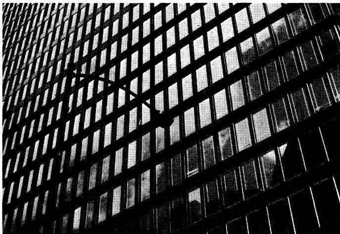
Fig 5. Stora inglasade ytor släpper direkt in strålningsvärme.
