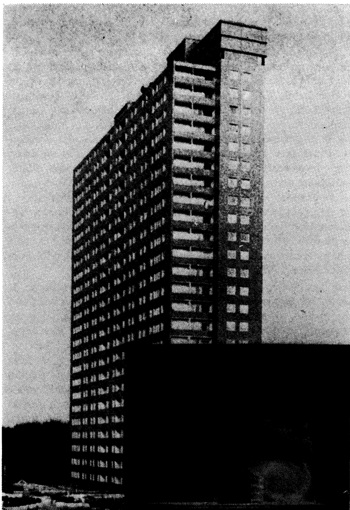
Fig 6. Höghus som står upp ur omgivningen för med starka höjdvindar till gatunivå som synes på den infällda vindtunnelbilden
