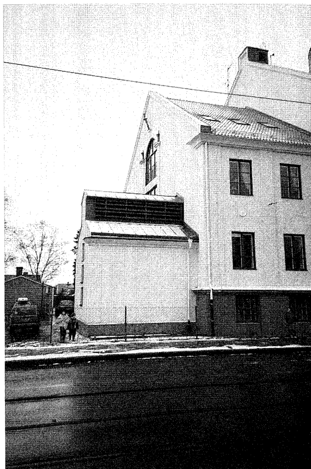
Uteluftsintaget är placerat på en tillbyggnad vid skolans gavel.
