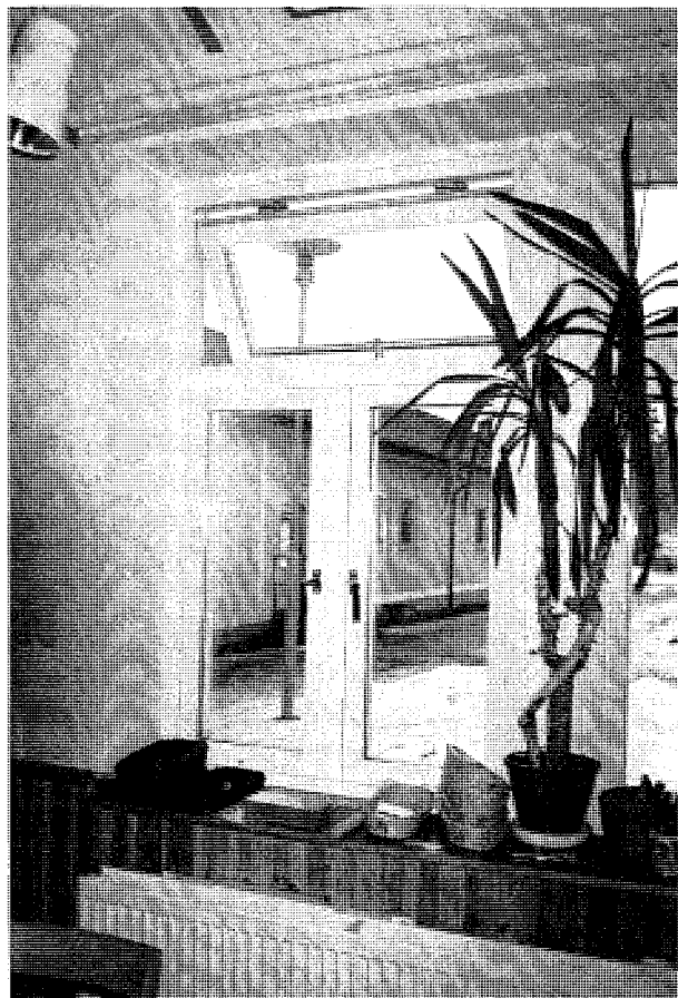
Uteluftsdonen syns som små spjäll i fasaden, under fönster. Fasadfönstren är genomtänkta med tanke på att ge goda vädringsmöjligheter. Överfönstren som kan vippas upp minskar kalldraget vid vädring.
