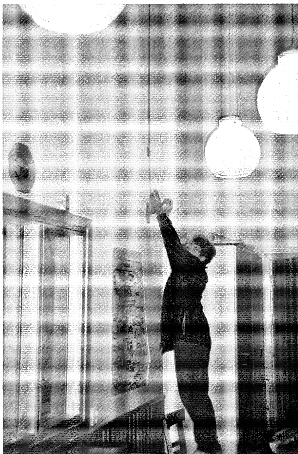
De högt sittande fönstren öppnas och stängs med hjälp av en handvev.
