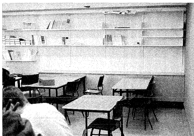
Tilluftsdonets ser ut som en bänk längs innerväggen.
