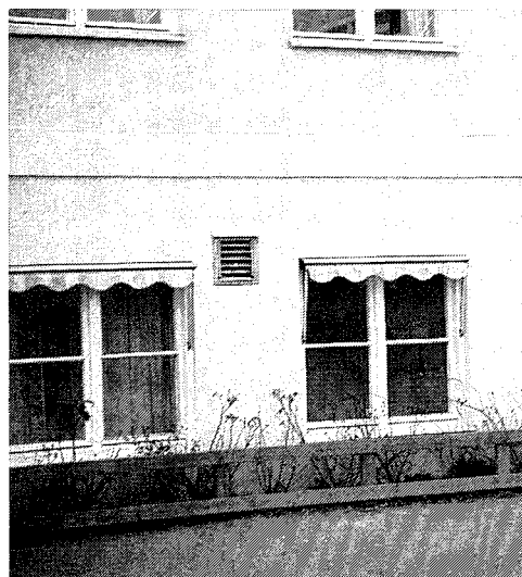
Fönstren på österfasaden har markiser.
