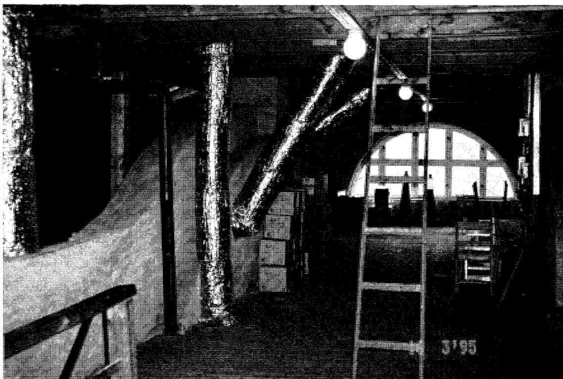
På vinden finns gott om utrymme för att dra frånluftskanaler.
