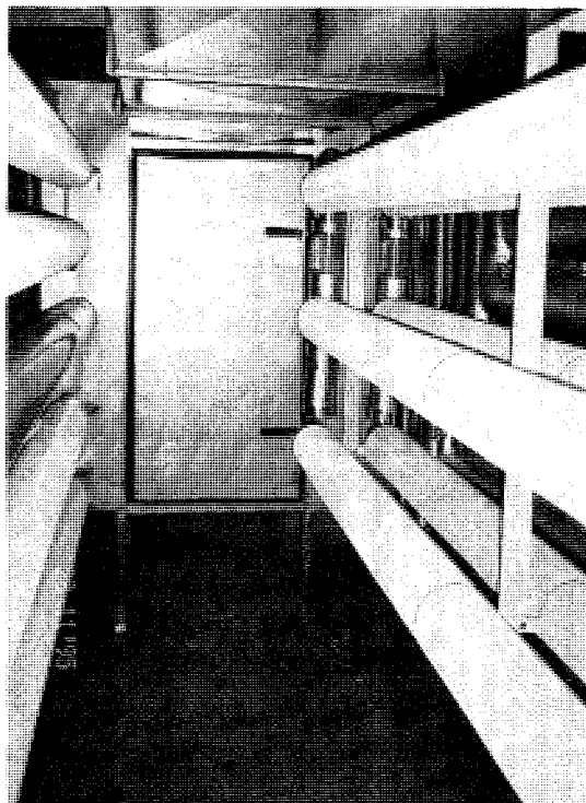
Eftervärningsbatteriet behöver sällan användas.
