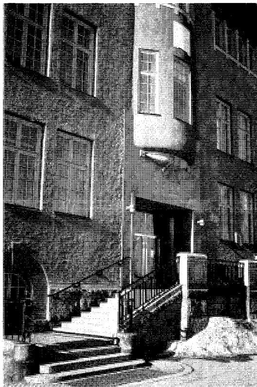
Entrén mot skolgården i öster.
