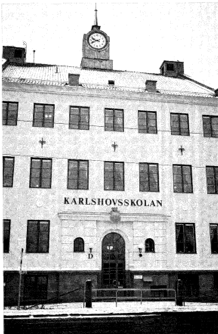
Karlshovsskolans fasad mot nordost.
