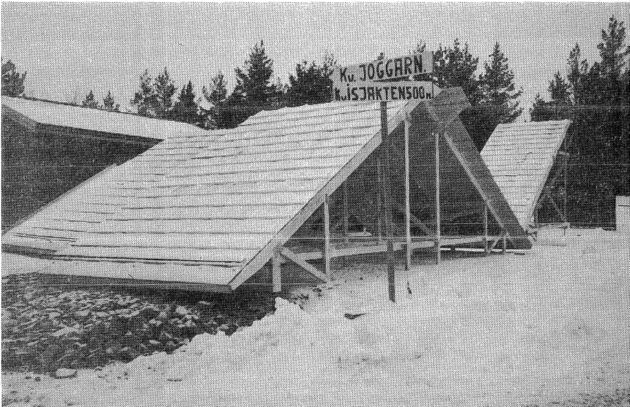
Fig 5.6.2.2 Förtillverkade taksektioner inom Kv Joggaren.
