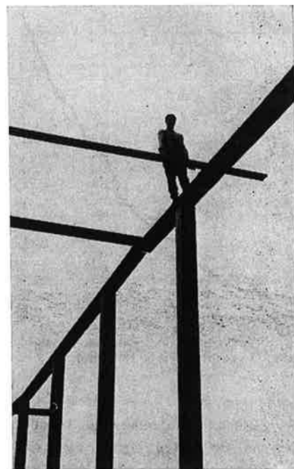
Fig. 6. Montering av stålstomme.
