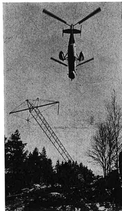
Fig. 3. Resning av kraftledningsstolpe i aluminium för Konti-Skan.
