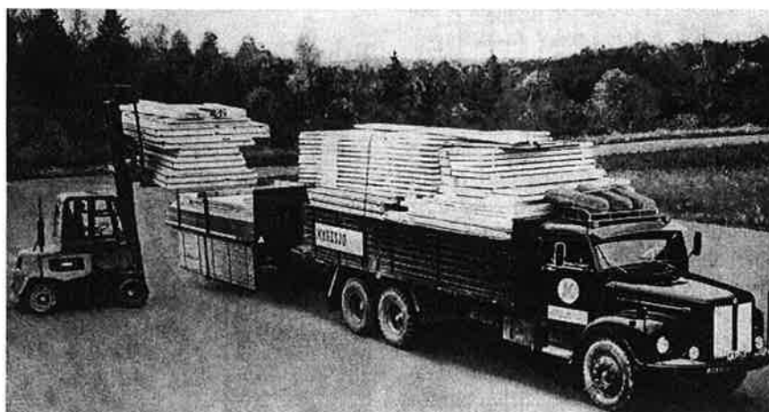
Fig. 14. Färdig byggsats för helt hus lastas på bil (Myresjöhus).
