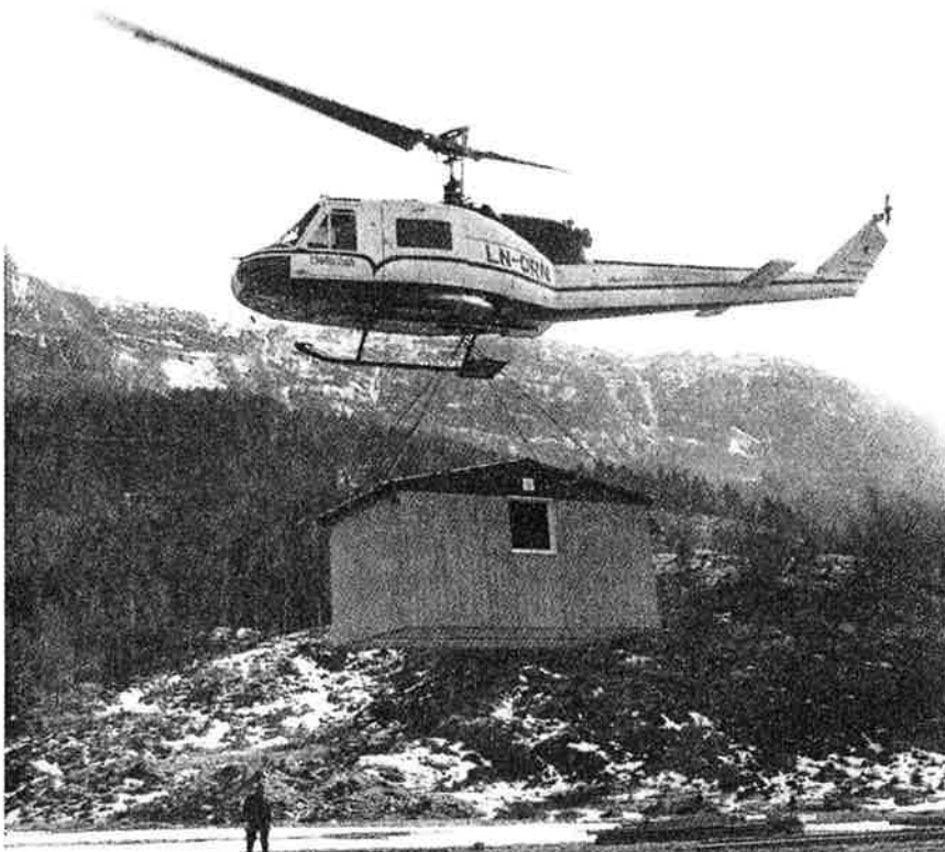
Fig. 12. Helikoptertransport av hel byggnad som storelement i Norge.
