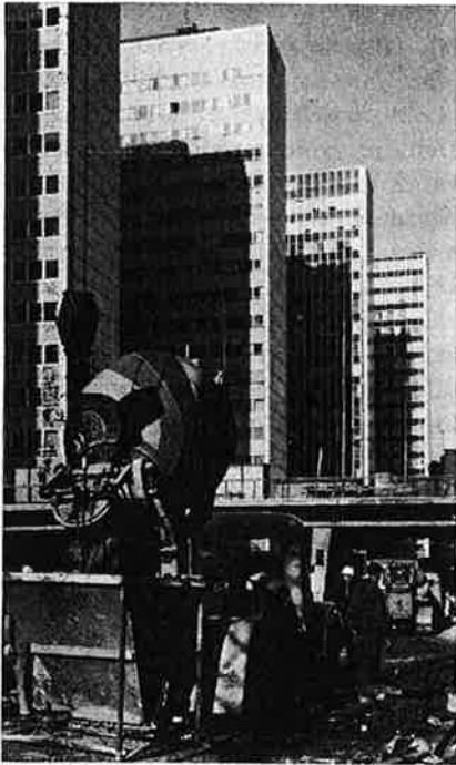
Fig. 2. Från bil kan fabriksbetongen transporteras direkt till gjutform med en 3 t kranbask.
