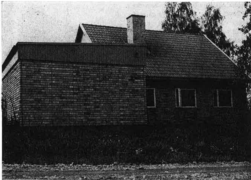
Fig. 10. Villa och garage (i Ormsta, Vallentuna) uppförda av fabriksstillverkade tegelement.
