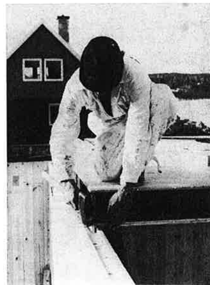
Fig. 9. Byggsystem enligt decimetermodulprincipen (samtliga element 20 x 20 cm i tvärsnitt); montering av vindsbjälklag (Elementhus, Mockfjärd).
