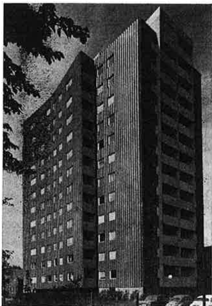
Fig. 2. Profilerad aluminiumplåt som fasad på bostadshus (kvarteret Jätten, Jönköping).
