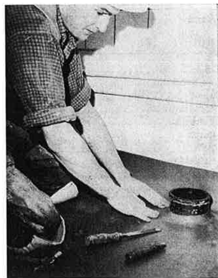
Fig. 3. Påläggning av vinylmatta.
