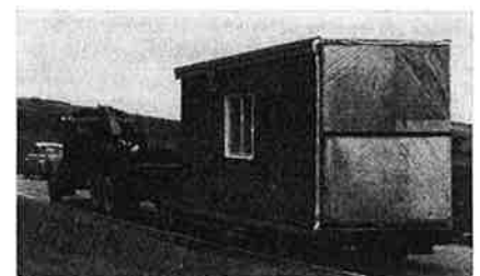
Fig. 15. Transport av skolhus i volymelement med fasad av spiktegel.
