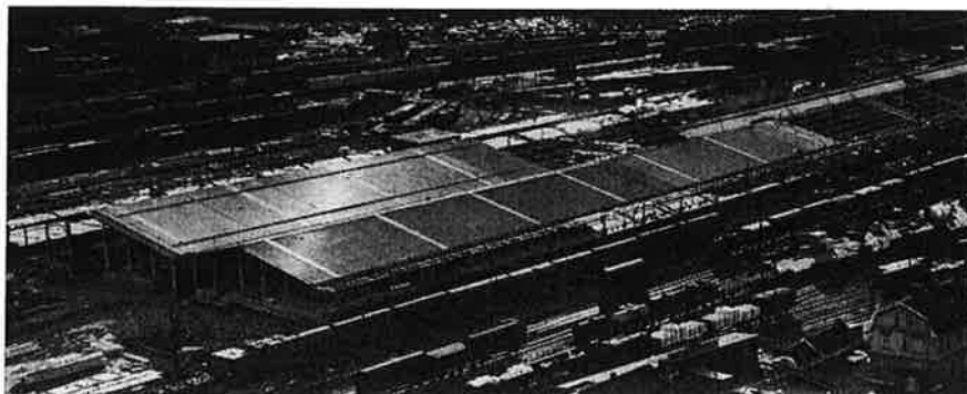
Fig. 5. SJ:s knutpunktsmagasin i Göteborg med 40 000 m 2 aluminiumtak av trapetsplåt samt stomme av HSI-stålbalkar.
