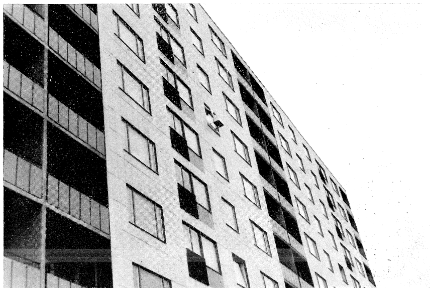
Fig. 4. Husfasaden mot söder med termografbur och solarimeter.
