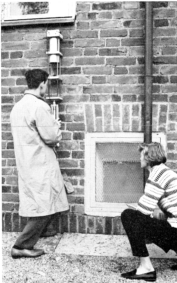
Fig. 41. Fotografering av fasadens solavskärmning med globoskop.
