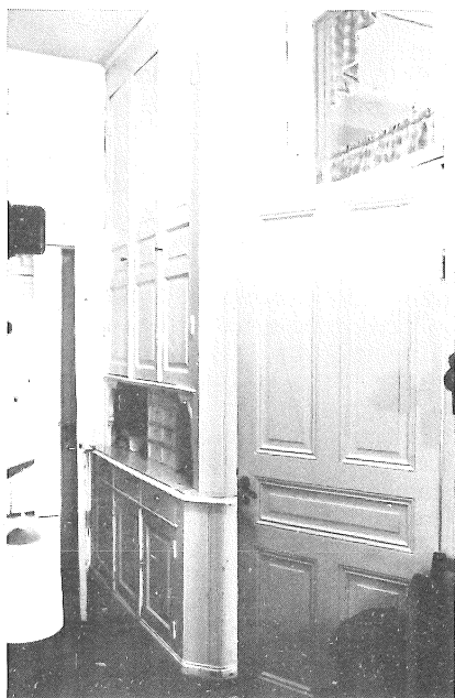
c) Tidstypiska, enhetliga snickerier, fungerande skåpinredning
