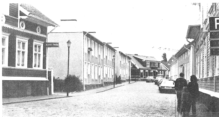
Fig. 1.3 c "Där skälen för bevarandet av en byggnad eller en miljö äro av väsentligen estetisk art, måste man ställa sig frågan om det inte vid en nybebyggelse kan skapas något av samma konstnärliga kvalitet, som utmärker den esisterande bebyggelsen. Om så är fallet, kan givetvis inte dennas estetiska företräden ensamma tillmätas avgörande inflytande vid bedömandet av frågan." (SOU 1947:26)
