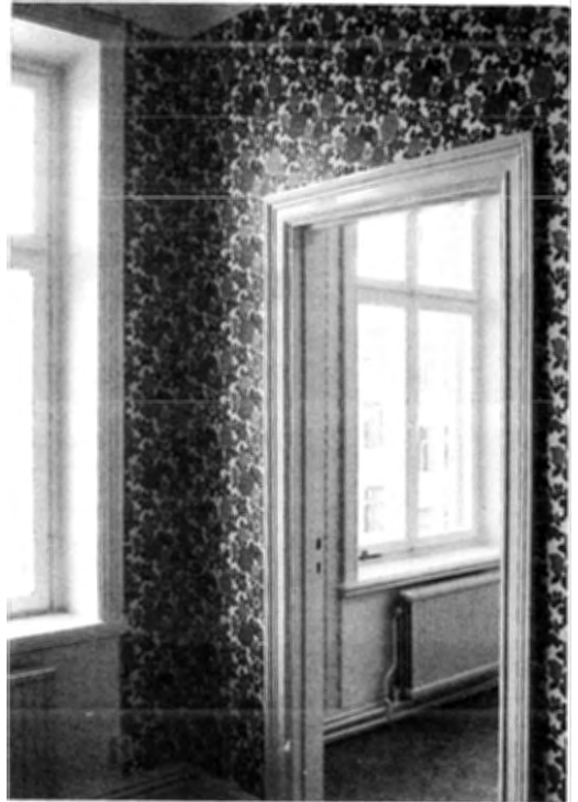
FIG 3.104 Övre listen avlägsnas. Nu är det en fotsockel
