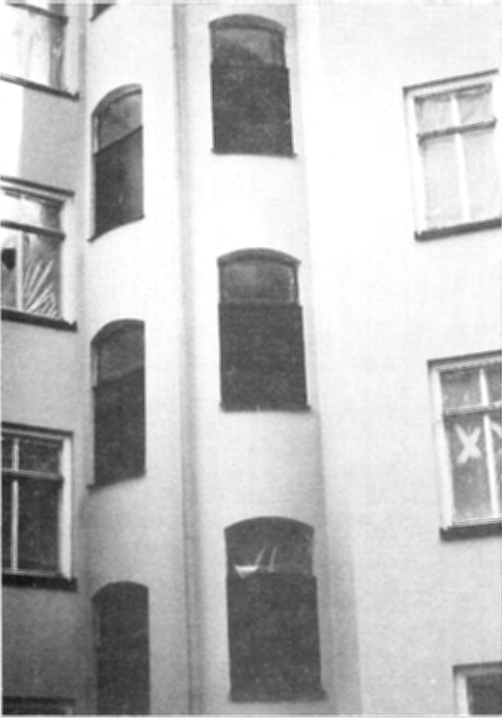
FIG 3.13-1.14 Igensättning av nedre del av befintligt fönster
