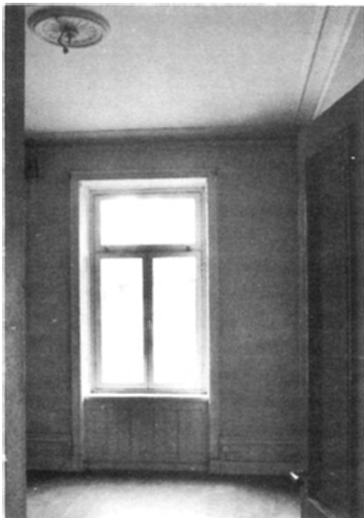
FIG 3.91 Rum med vackra stuckaturer. (Nytt fönstersnickeri)
