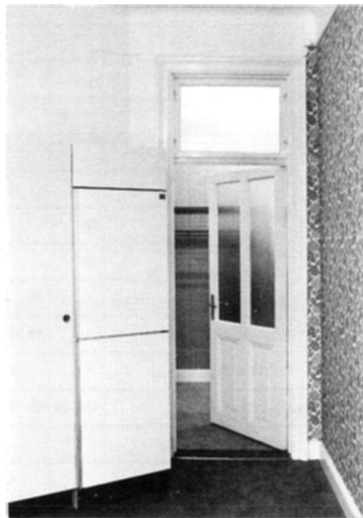
FIG 3.98 Klarglas har bytts till ogenomsiktligt. En fördyrande åtgärd
