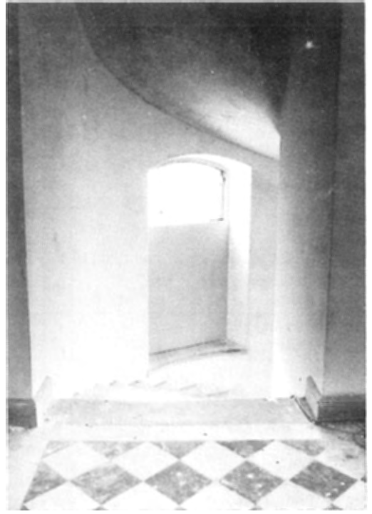
FIG 3.13-1.14 Igensättning av nedre del av befintligt fönster
