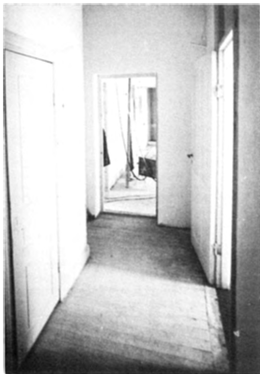
FIG 3.96 Nya tamburdörrar monteras
