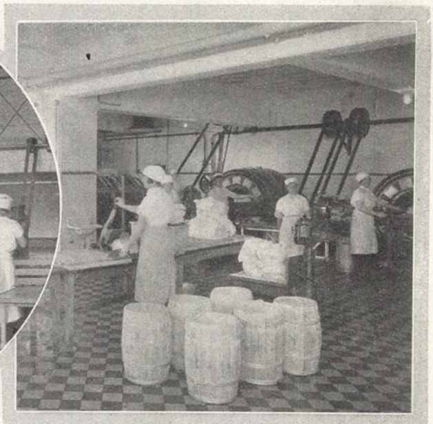
Smörrummet, där dagligen tusentals kilo smör förpackas och distribueras.
