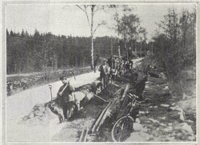
Från jättearbetet med nedläggningen av rikskabeln Stockholm—Göteborg. Grävningssmaskinen arbetar. — Kabeln skärvas och kontrolleras. — Schaktningsarbete i den stenbundna marken. John W. Johansson foto.
