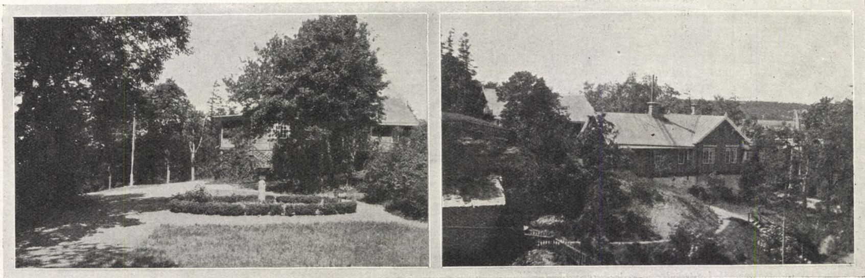
Från prins Bernadottes egendom Fridhem på Gottland, som nyligen delvis härjats av eld. T. v. själva villan. T. h. det nu nerbrunna huset, tidigare bebott av prinsessan Eugénie. Foto Judith Nyström.
