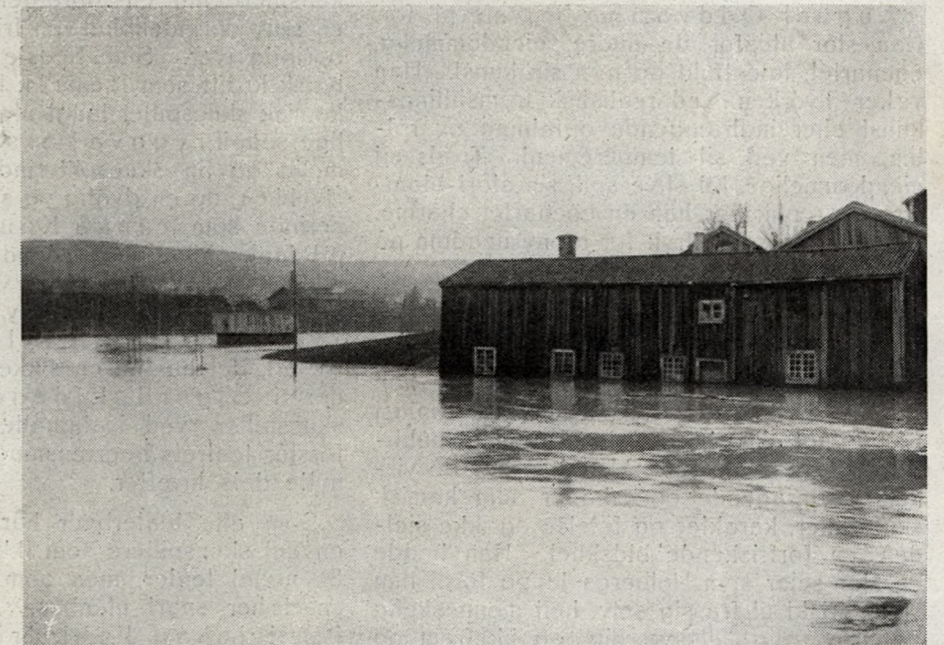
der vatten; (Sundsvall). 8. Ett broras i Sollefteå. 9. Fagerdal vid Sundsvall. 10 Järnvägsbanken rasar (Sundsvall). 11. Sidsjöbäcken vid Sundsvall i uppror. 12. Störbron i Sundsvall rasar. 1, 3, 8, Therese Karlström foto, 2, 4, 5, 6, 7, 9-12 Ateljé Waagsböe.
