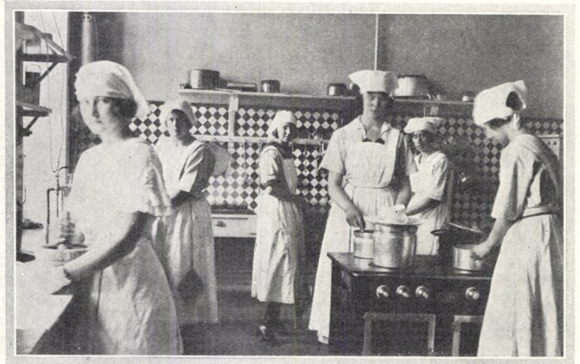
Arbete i "nya köket".
