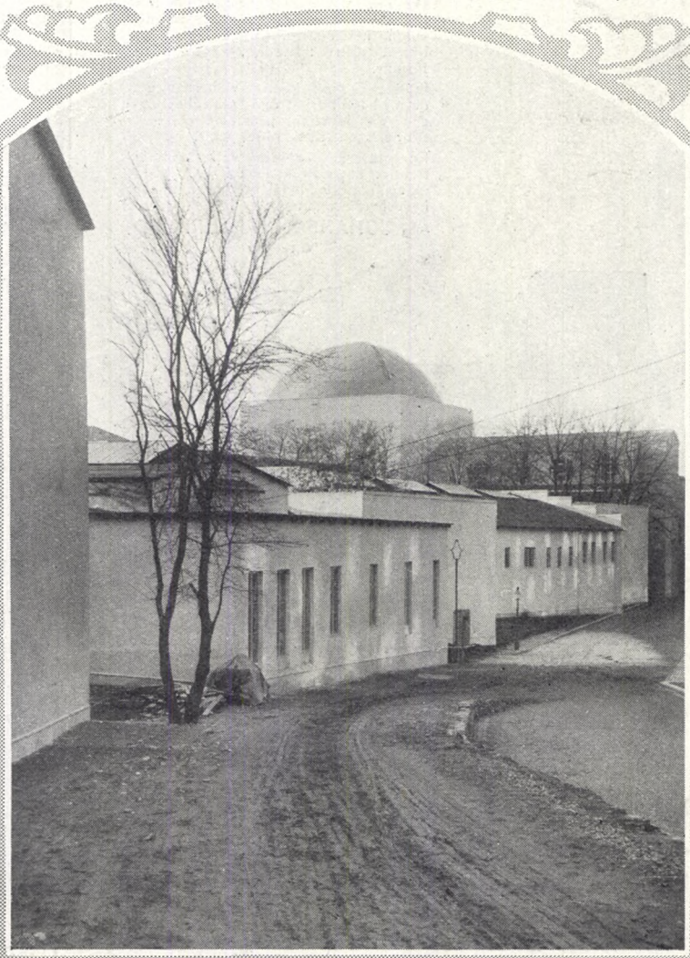
Parti av huvudingången med dess ståtliga gröna kupol, som blir ett av fältets mera iögonenfallande partier.
