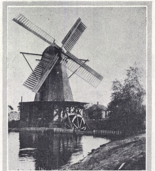
I många trakter av Närke bidraga de gamla väder- eller vattenkvarnarna till att ge landskapet dess säregna karaktär. Denna kombinerade vatten- och väderkvarn, numera ombyggd för elektrisk drift, finns i den gamla kulturbygden Konsta med minnen från både sten- och järnåldern, intill Sköllersta.
