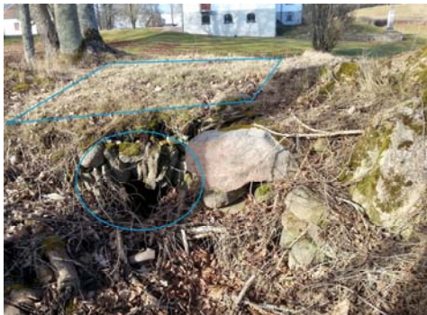
Fig. 52. Källarvalvs öppning, i cirkeln, under husgrund, markerad fyrkant. Lämningar sedan 1700-talet. Foto: C Haugerud 2016
