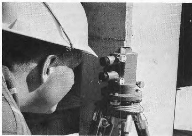
Fig. 52. Optisk lodning av pelare. Lod, Kern OL. Optical plumbing of column. Plummet, Kern OL.
