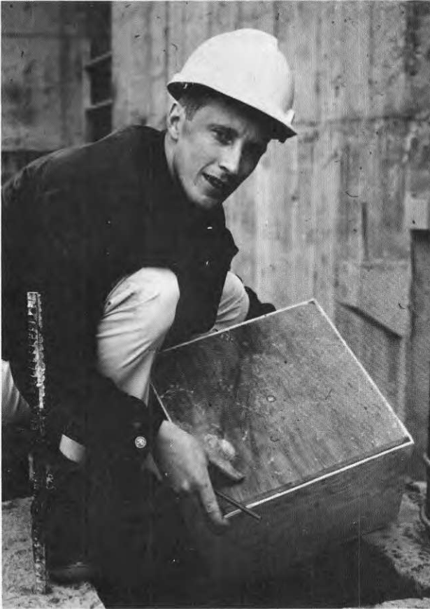
Fig. 12. Inmätning av pelarholkars lägen. Pelarcentrum realiserades med en punkt på en låda som placerades mellan styrlinjalerna. Punkten lodades upp till nivå med holkens kant med hjälp av optiska lodet på teodoliten. Punktens läge markerades med ett märke på ett snöre vars läge säkrats med märken på holkens kanter.
