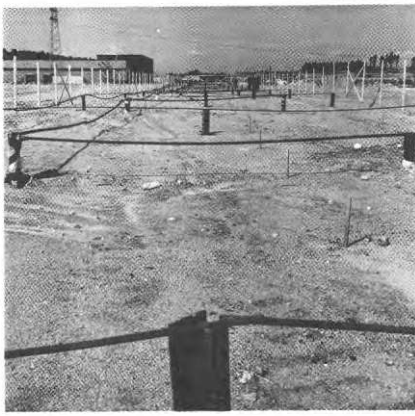
FIG. 1. Elektroosmotisk avvattning av lera under 6—7 m sandfyllning vid Scania Vabis, Södertälje. Elektrodena av järnvägsräler är förbundna i längs- och tvärlinje med armeringsjärn. Anoderna och förbindelsejärnen mellan anoderna är plastisolerade.
