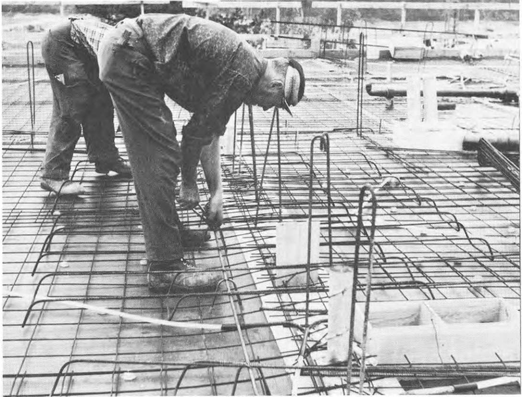
Montering av armering
