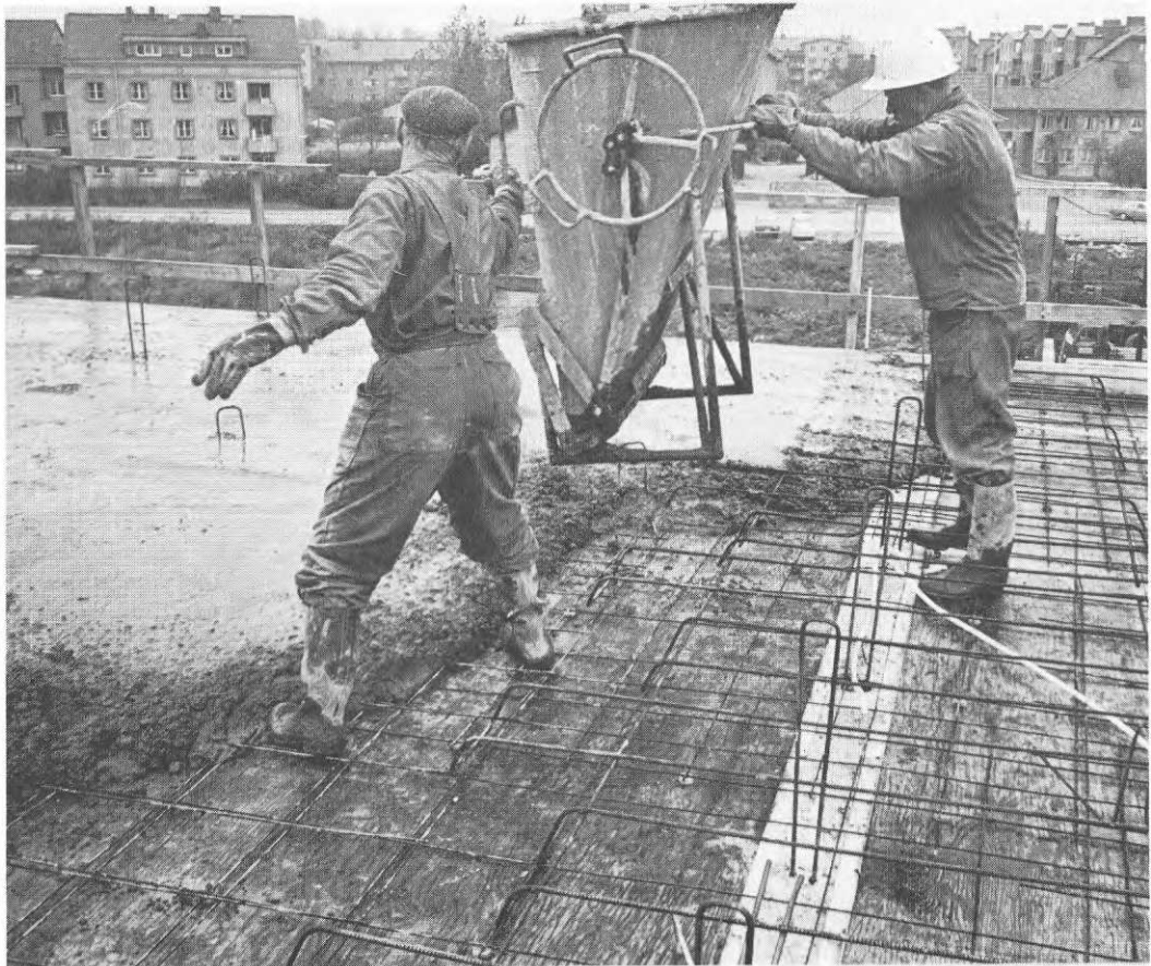
Mottagning av hisskorg med betong
