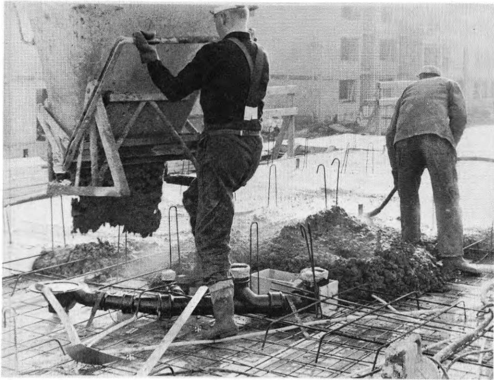
Tömning av betong på bjälklagsformen
