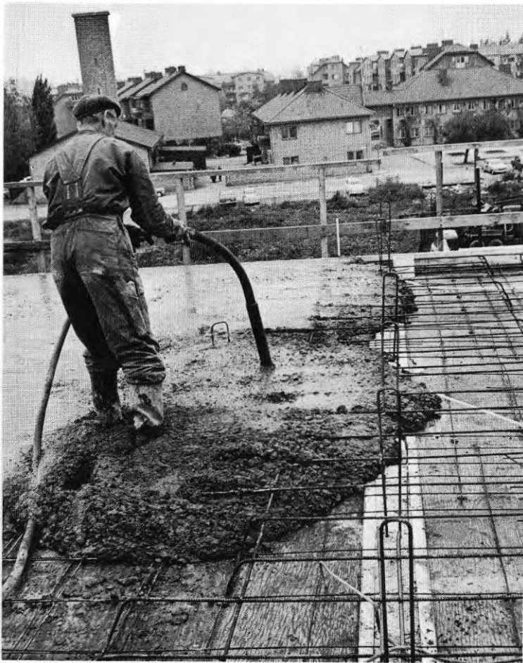
Behandling av betongen med vibrering
