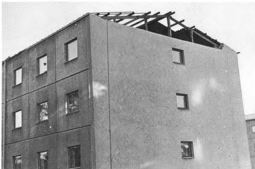
FIG. 4.6.1 Skadad gavelspets av lättbetong. Damaged gable of lt.wt. concrete.
