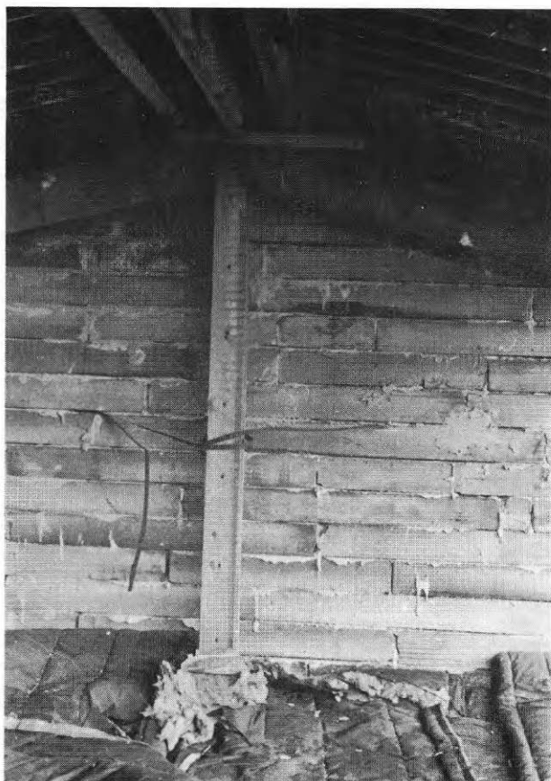
FIG. 4.6.1 Skadad gavelspets av lättbetong. Damaged gable of lt.wt. concrete.
