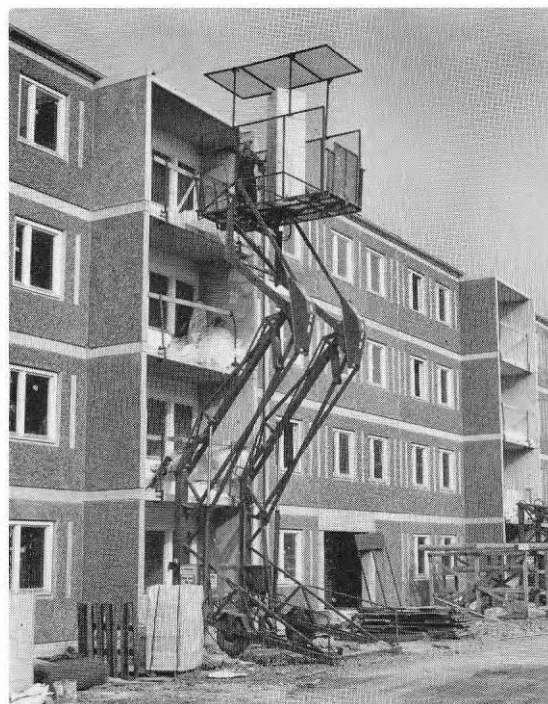
2 Inredningsmaterialet tas in via balkongerna med hjälp av lätt flyttbar hydraulisk hiss
