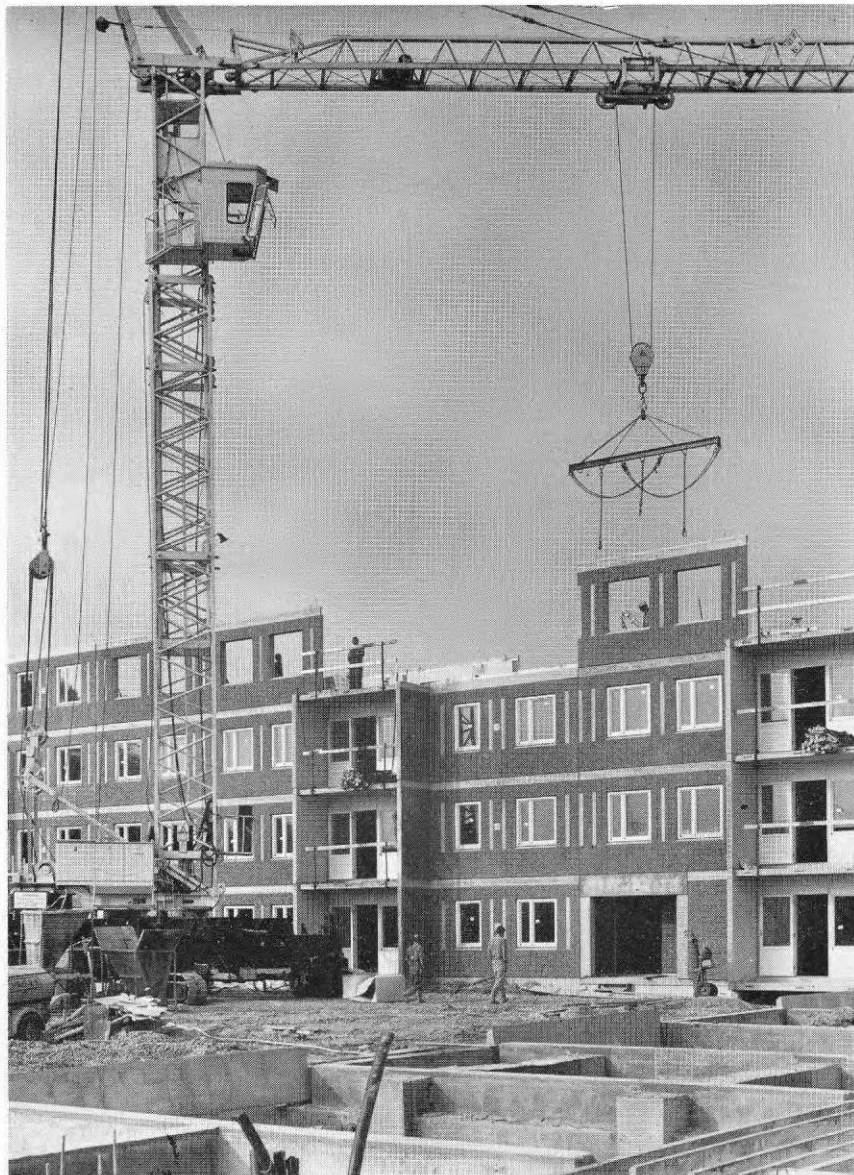
1 För montaget används en bandgående tornsvängkran med löpkatt. I förgrunden syns en montagefärdig grund.
