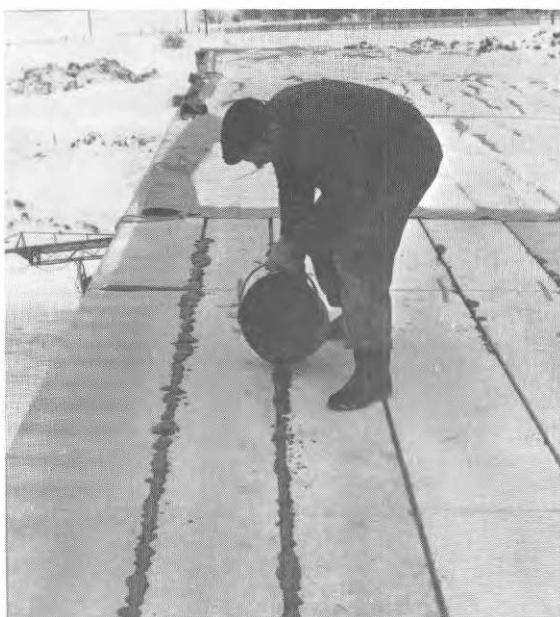
FIG. 39. Fogning av lättbetongplank med hjälp av hink.
