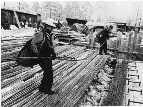
FIG. 12. Frambärning och upplyftning av järn är ett tungt arbete som ställer stora krav på rygg och leder. Det är fördelaktigt att forsla fram knipporna hela ända till rullbanan för att undvika att järnen kommer i oordning. Vid manuellt arbete bör därför knippornas vikt inte överstiga 100 kg. Om möjligt bör detta arbete utföras med mekaniskt hjälpmittel, t.ex. lyftkran.
