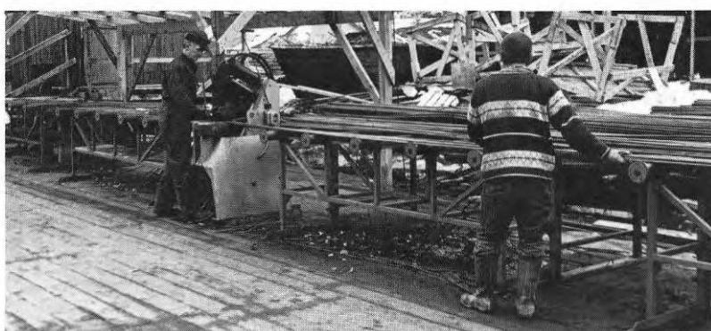
FIG. 10. Studerad modifierad armeringsstation.
