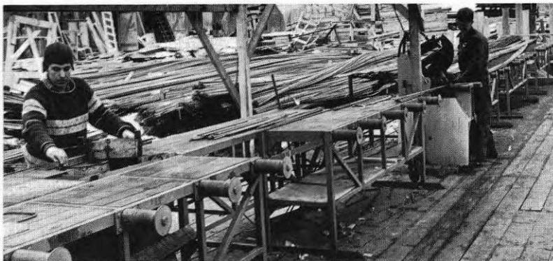
FIG. 8. Vid den modifierade armeringsstationen sker klippning och bockning av järn i samma arbets höjd. Klippning och bockning kan också bekvämt utföras samtidigt. Bänkarna lutar i järnets transportriktning och rullarna har kullager.
