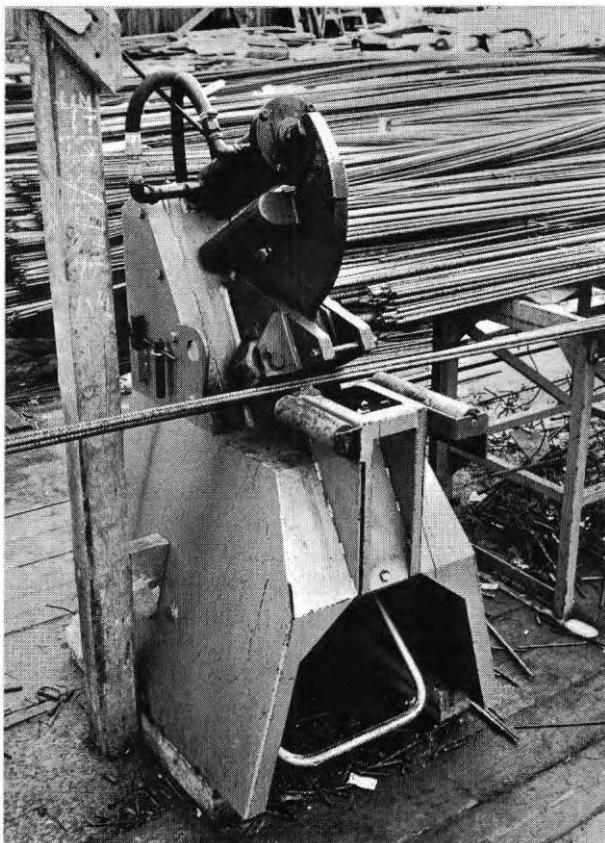
FIG. 3. Modifierad klippmaskin (prototyp), där bl.a. horisontell transport och iläggning av järn underlättats samt reglagen fått en bekvämare placering i förhållande till den ursprungliga. Maskinen har konstruerats av AB Westman och Lundmark.
