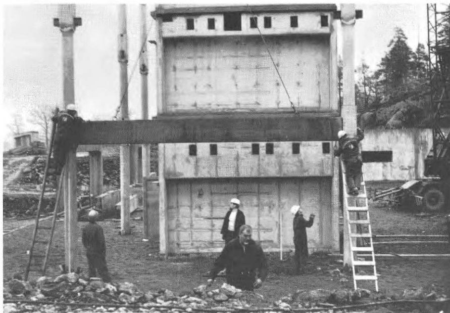
FIG. 17 b. Montering av balk. Erection of beam.
