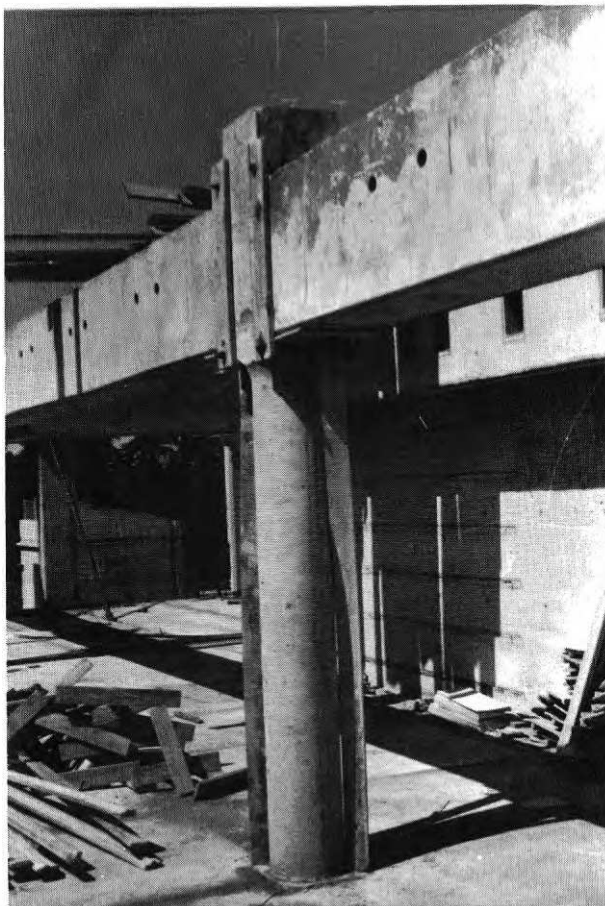
FIG. 34. Formsatt an- slutning mel- lan pelare och balk.
