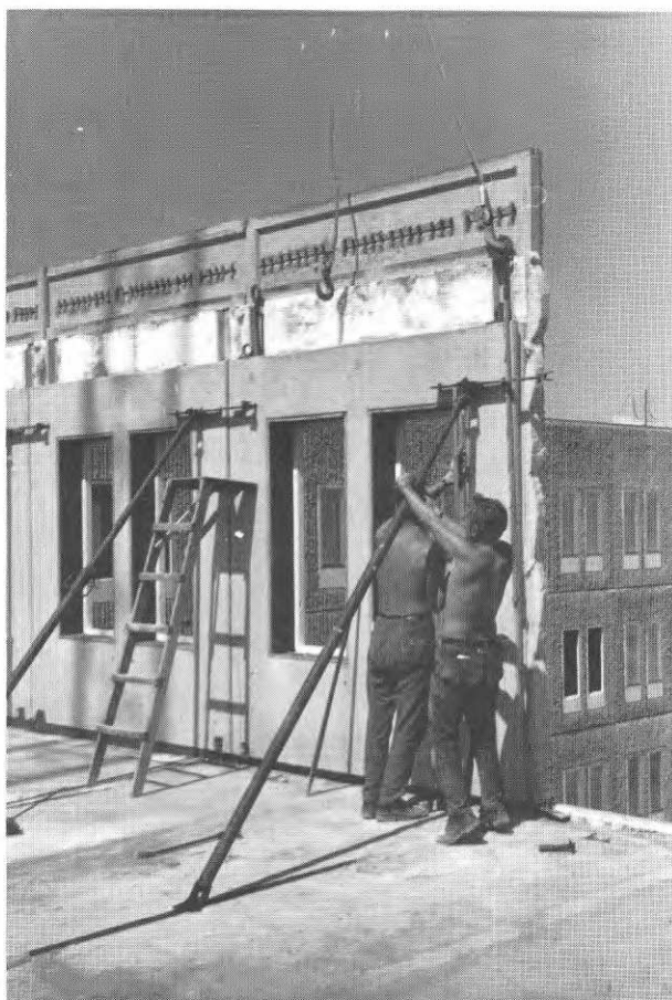
FIG. 24 f. Avvägning och justering av fasadelementets lodläge. Levelling and adjustment of external wall panel to vertical.
