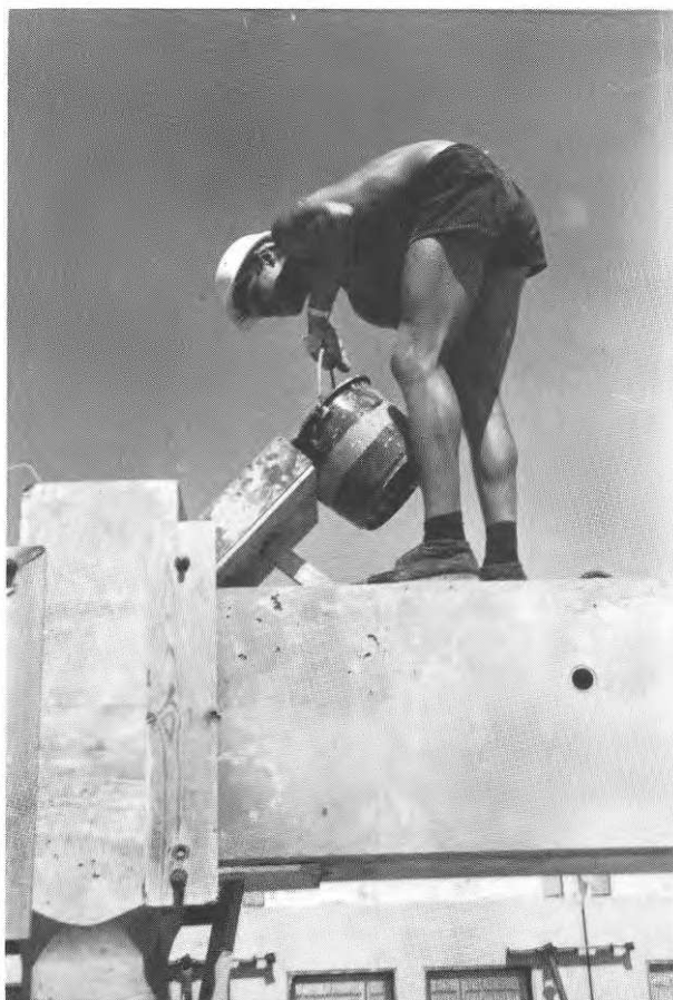
FIG. 43. Gjutning av fog mellan pelare och balk. Casting of junction be- tween column and beam.
