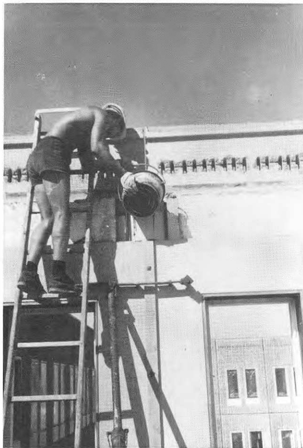
FIG. 38. Gjutning av fog mellan fasadele- ment.
