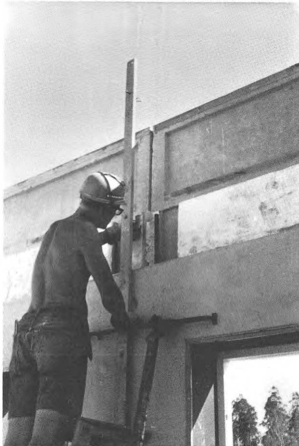
FIG. 37. Formsättning av vertikalfog mellan fasadkomponenter.
