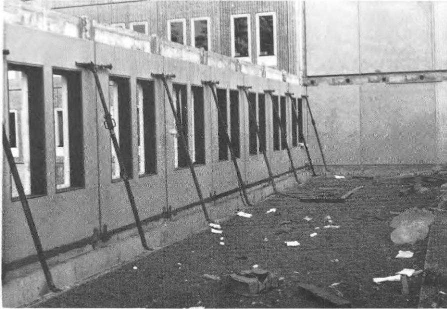
FIG. 24 c. Förankring av stag i plastgjuten konstruktion. Anchorage of ties in in-situ cast structure.
