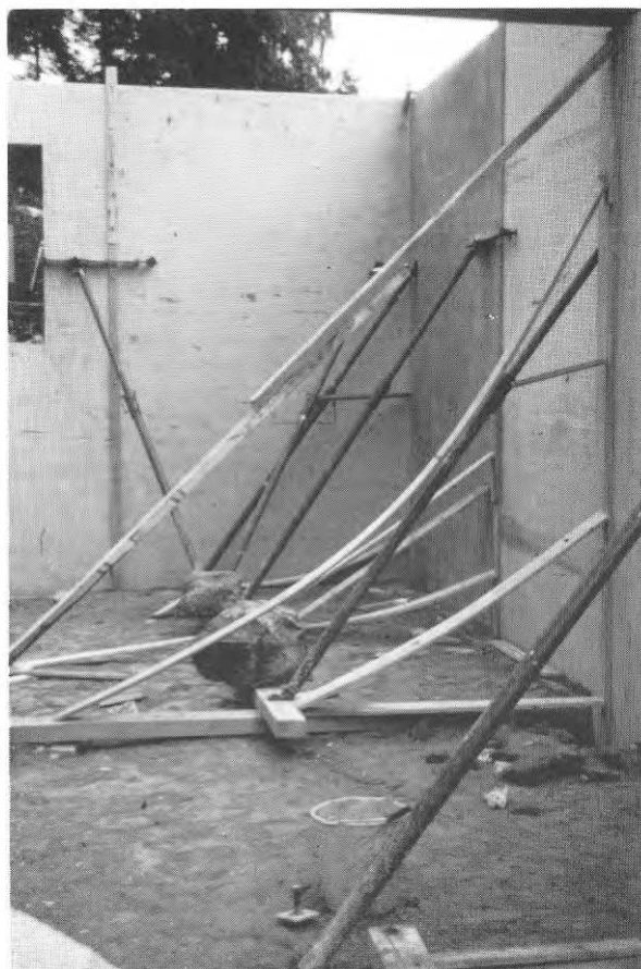
FIG. 27 b. Monterade väggelement stagade i provisoriska träreglar och formsatta för foggjutning.
