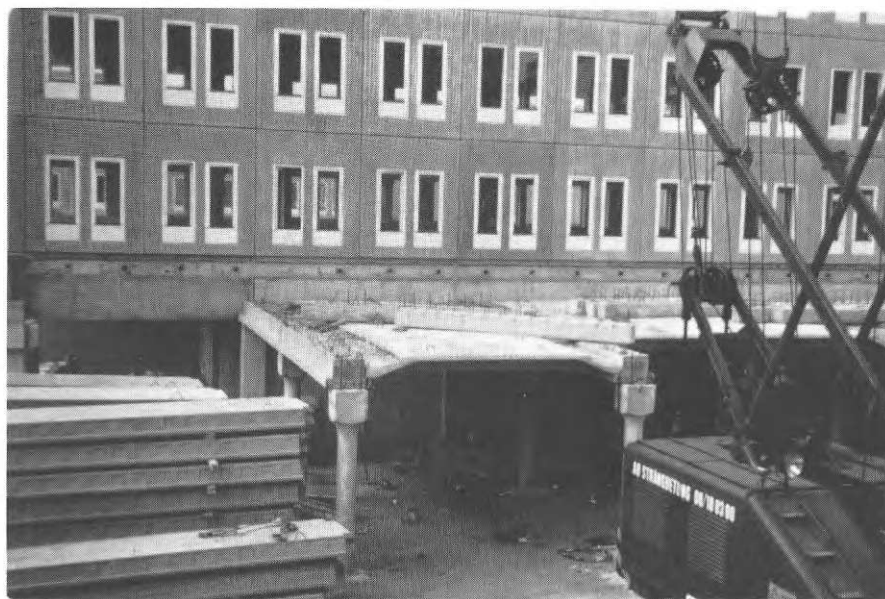
FIG. 26 b. Gårdsbjälklag bestående av TTK-kassetter under montering.
