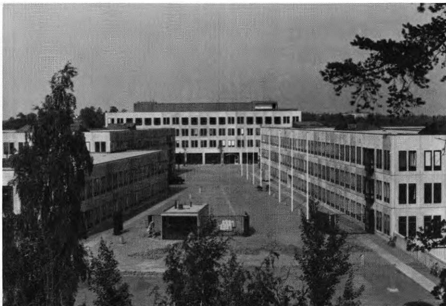
Kv. Ivar till vänster, kv. Ludvig till höger och kv. Helge längst bort.
