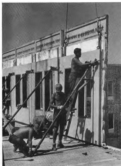
Montering av stag till fasadelement.
