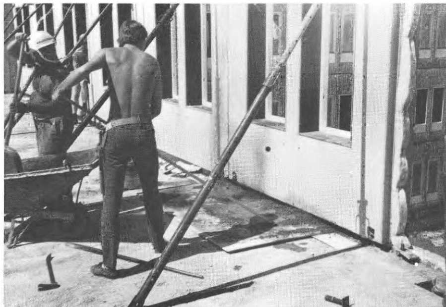
FIG. 39. Understopning av fasadelement. Grouting of external wall panels.
