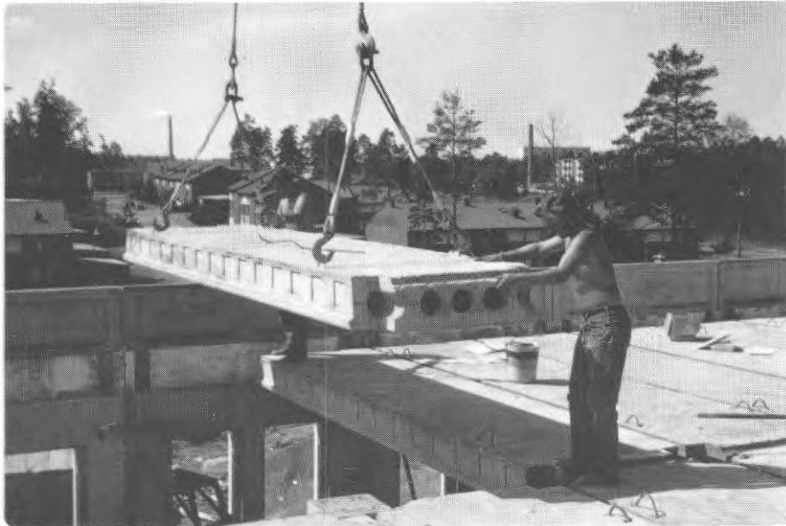
FIG. 18 b. Montering av hålbjälklagselement. Erection of hollow floor slab element.
