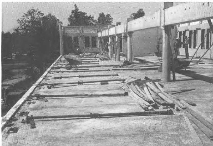
FIG. 24 b. Bjälklag förberett för montering av fasadelement.
