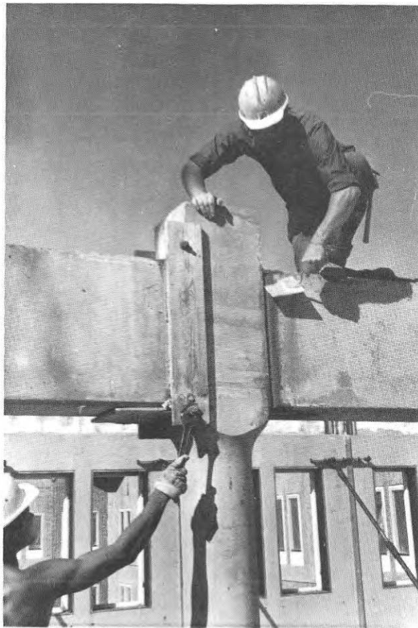
FIG. 36. Avformning och renskrapning av anslutning mellan pelare och balk.
