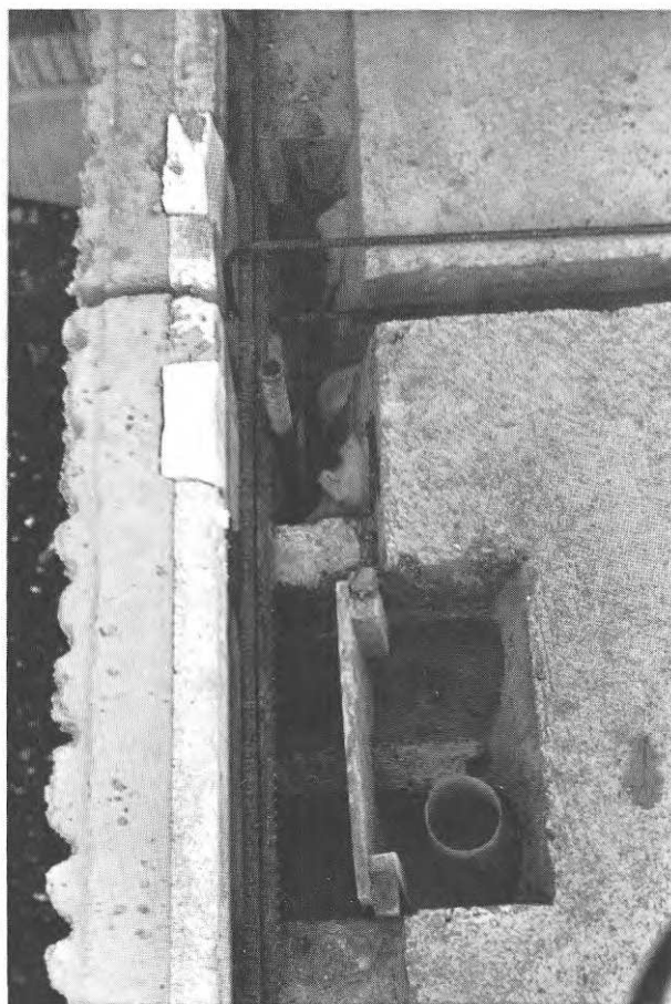
FIG. 31. Detalj av fog mellan bjälklagsplatta och fasadelement.
