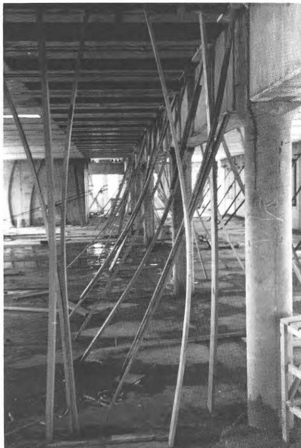
FIG 32. Formsättning av bjälklag före foggjutning.
