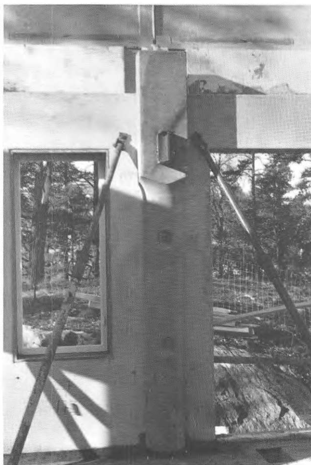
FIG. 23 b. Monterad halvpelare.
