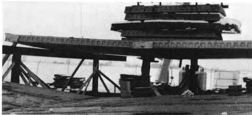
FIGUR 6. Fullskaleförsök vid firma A-betong i Bjuv. Liksom vid modellförsöken uppträder hörnlyft när mittpelaren avlägsnas.
