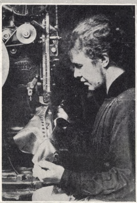
I en ändlös rad flöda skoringarna ur maskinen och tryckas in i kängskaften — ett enformigt och även tröttande arbete, när det här som alltid gäller att prestera största hastighet.
