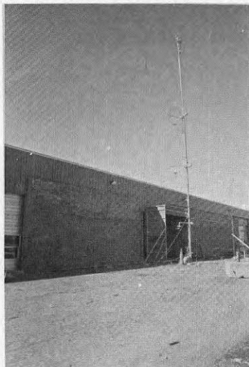
Figur 3.3 Mätmast framför port med monterad öppen sluss med återstyrningsskärm
