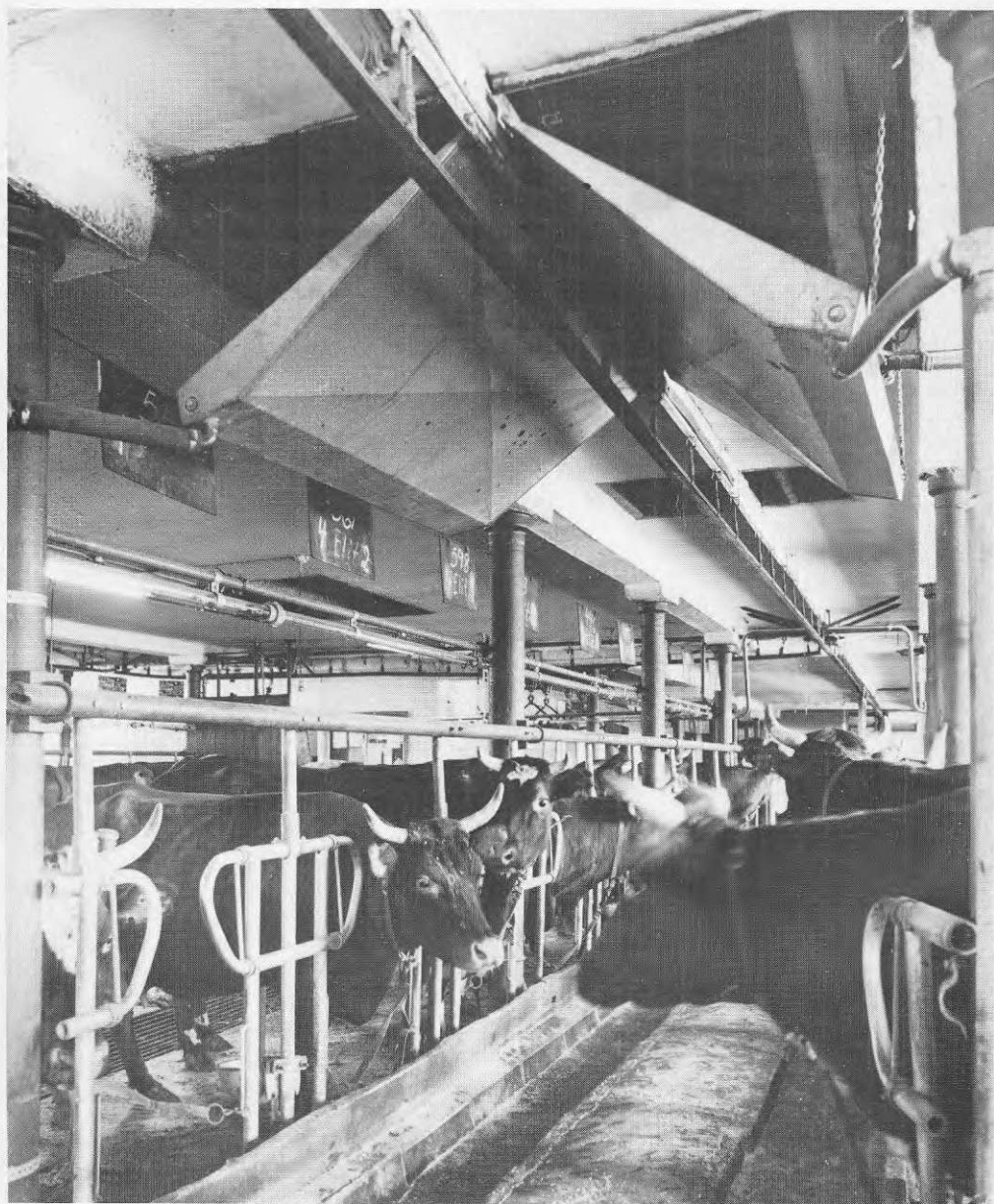
Fig 9 - Förångaren (värmekälla) med dropplådor, ladugård
