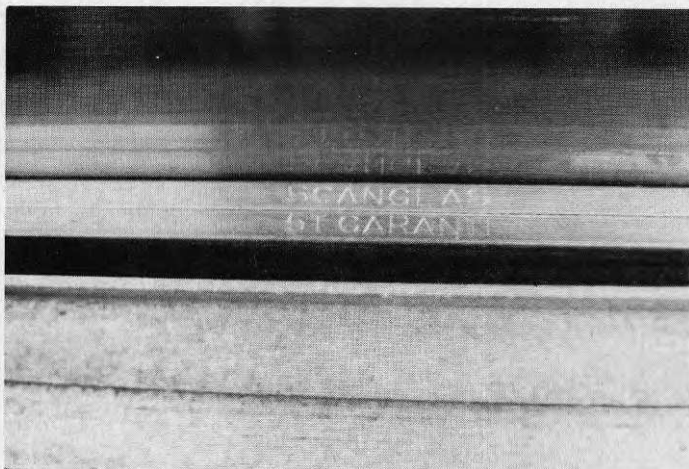
Foto nr 12. Elastiskt fogband som sjunkit ned i botten. Glasning enligt SIS 81 81 18.
