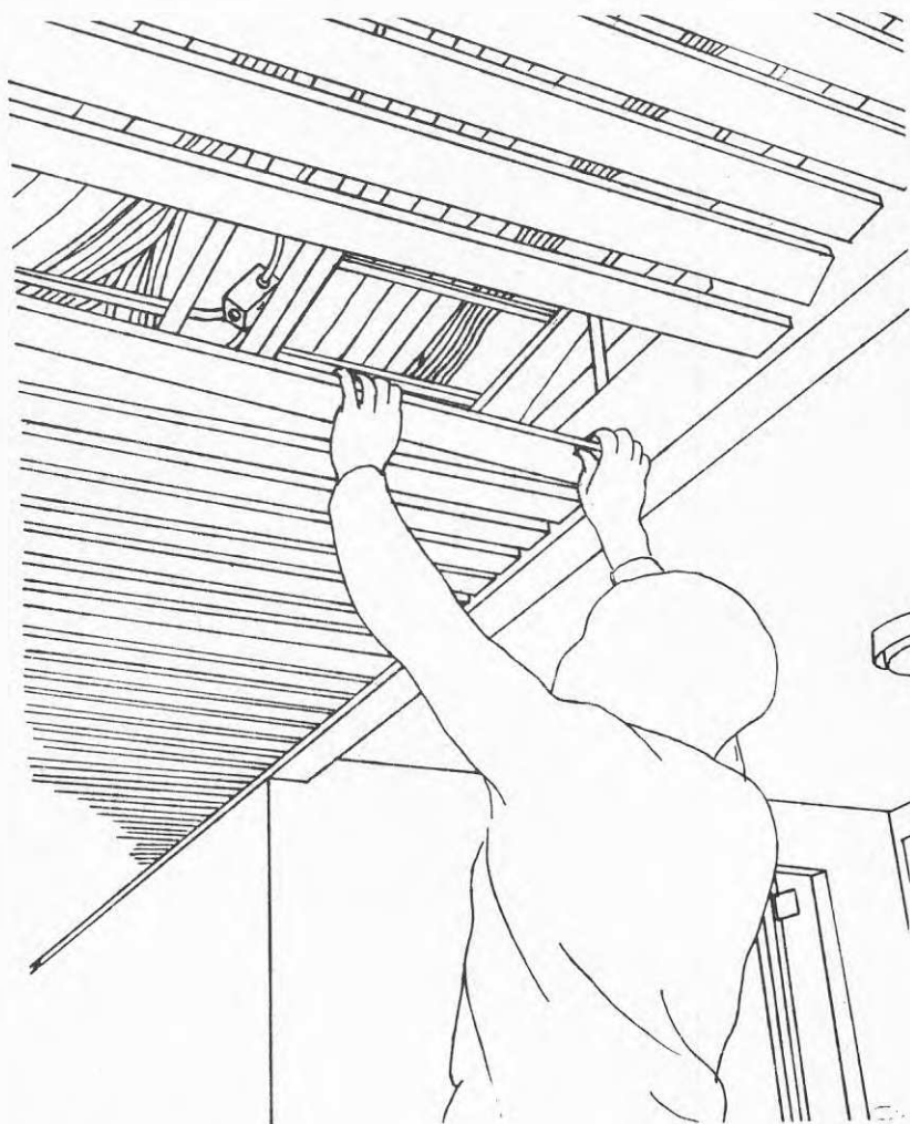
Fig. 8. AMS. Demontering av undertak på spridningsplan
